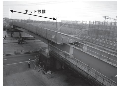
図-4 飛散防止対策用のネット設備
