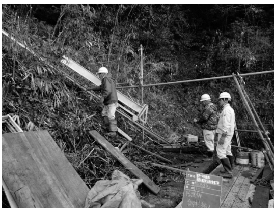
図-4 落石防護柵の搬入状況
