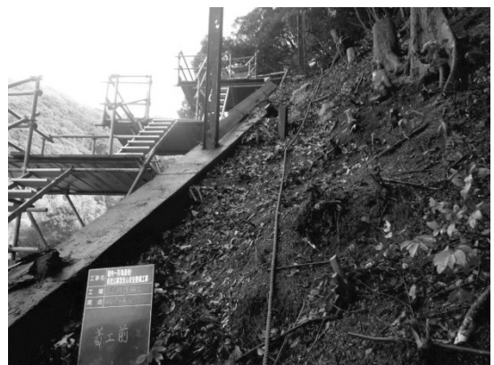
図-2 傾斜角46°の搬入路
