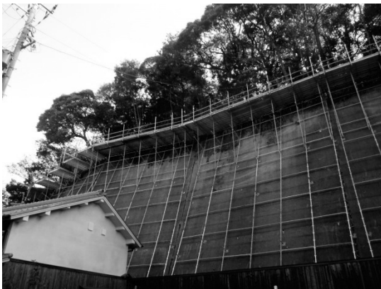
図-1 急傾斜地 高さ約20m
