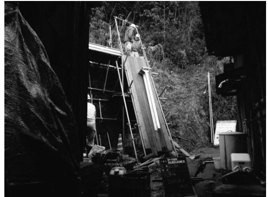
図-5 槽を使用した搬入状況
