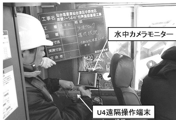
図-5 水中カメラでの玉外し状況確認
