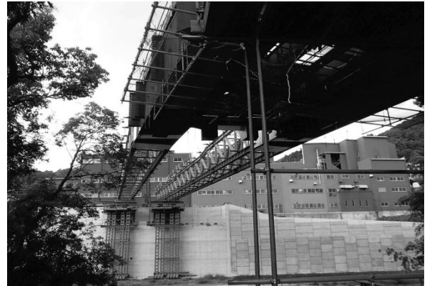
図-2 送り出し架設状況
