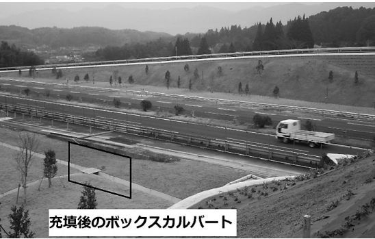
図-5 ボックス充填後の完成全景
