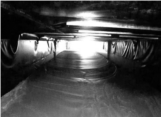
図-4 ボックス内充填状況
