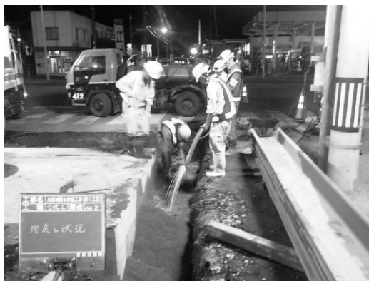
図-4 埋戻し状況
