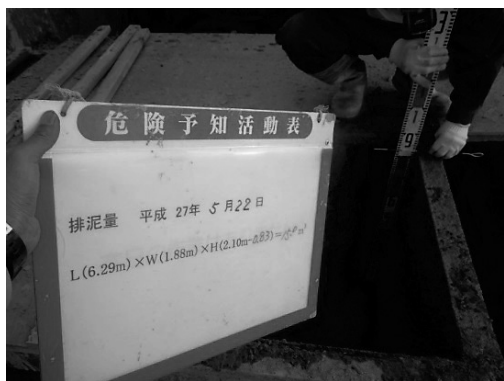
図-3 排泥量の測定
