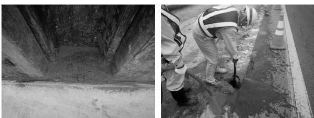
図-4 バイブレーターと水を併用した埋戻し
