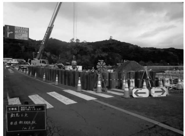
図-2 鋼矢板を利用した転落防止対策
