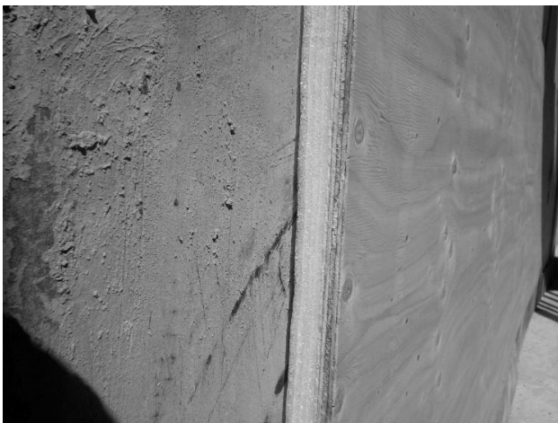
図-3 衝撃吸収材貼り付け（型枠設置）
