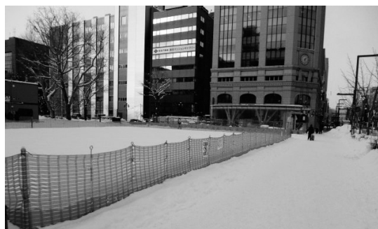
図-1 鉄ピン+1.0m ネットの立入禁止柵
