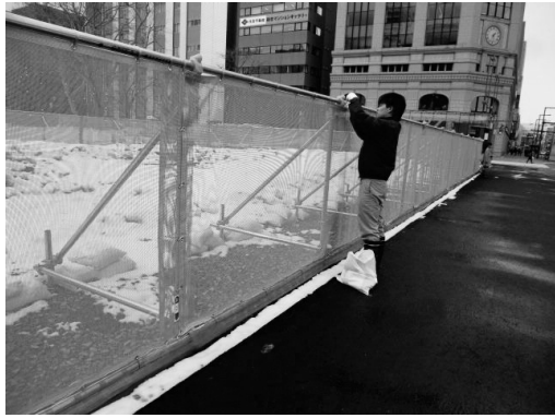
図-2 同系色のクランプカバー設置
