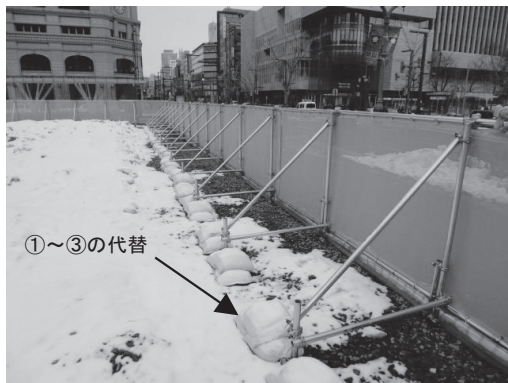
図-3 設置完了（土のうによる重り）
