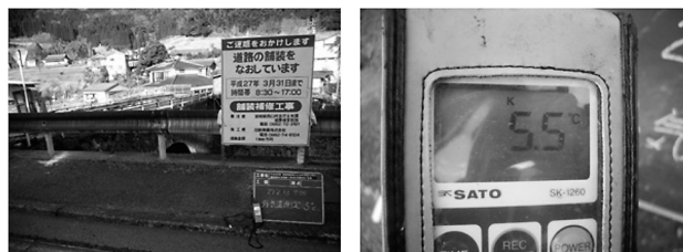
図-1 施工当日外気温
