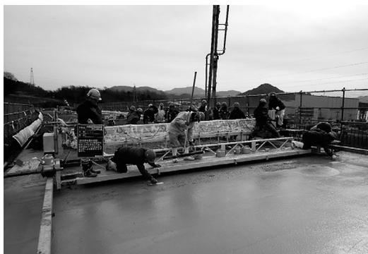
図-4 フィニッシャーによる締固め
