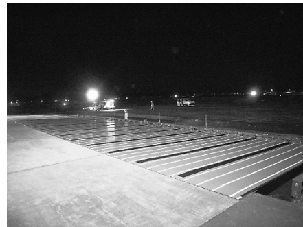
図-6 本施工状況写真
