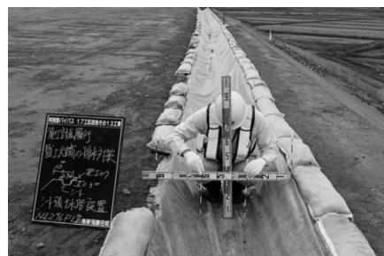
図-3 盛土天端土側溝
