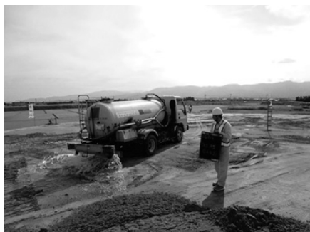
図-1 散水による含水比調整
