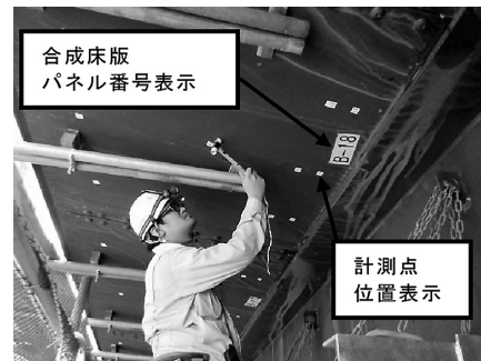
図-5 検査状況 (張出部)
