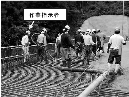
図-4 コンクリート打込み状況
