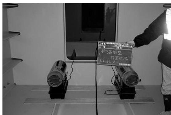
図-4 燃烧型ヒーター設置状況
