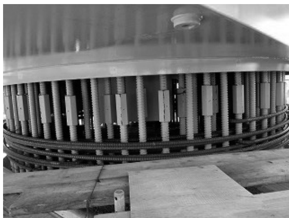
図-2 AP1剛結部鉄筋挿入状況
