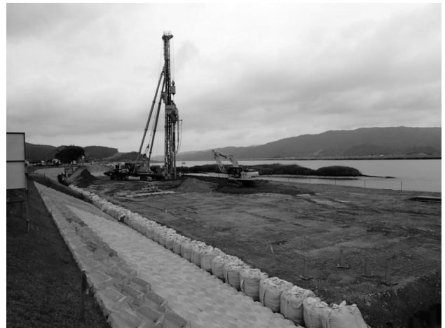
図-1 サンドコンパクション施工
