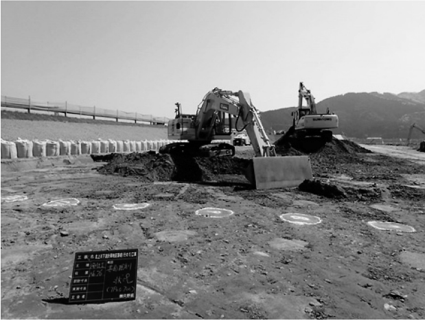
図-2 マシンコントロール機能搭載機施工状況
