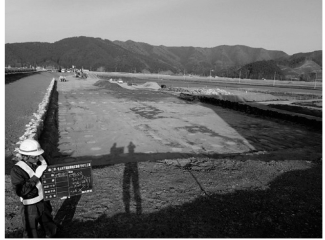
図-4 マシンコントロール制御による掘削完了 得られた。
