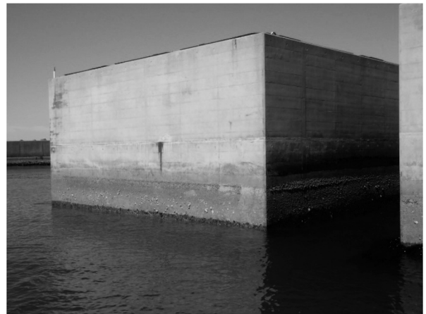
図-1 使用ケーソン全景
