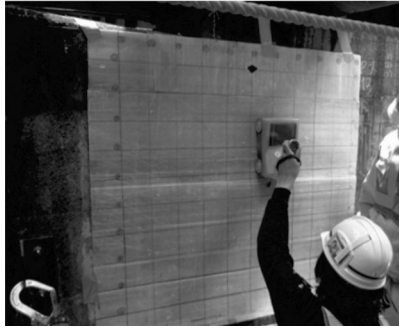
図-2 鉄筋探査作業
