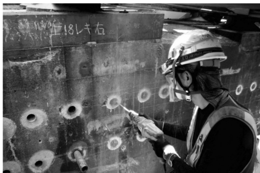
図-3 ハンマードリルによる先行作業
