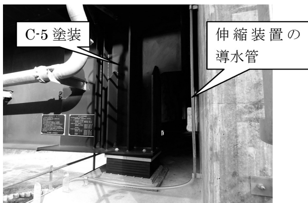
図-2 外面塗装・伸縮装置導水管
