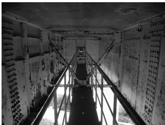
図-1 検査通路からの施工前状況（G5～G6桁間）
