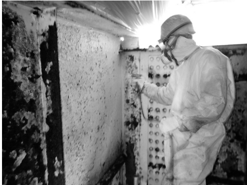
図-3 剥離剤塗布状況
