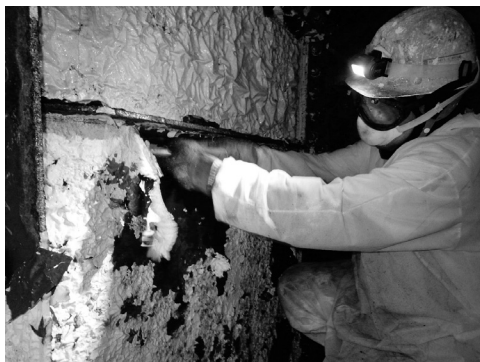
図-5 塗膜剥離除去作業
