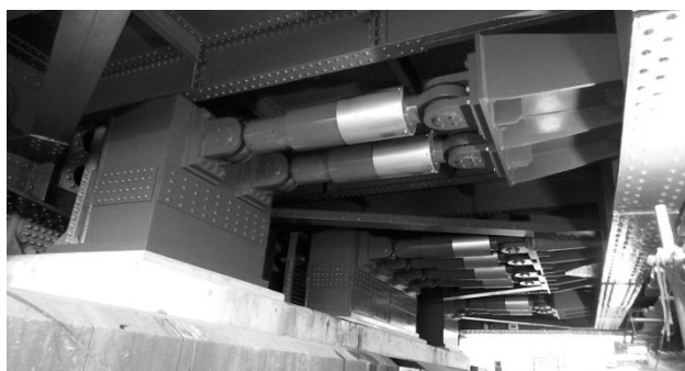
図-2 ダンパー設置完了
