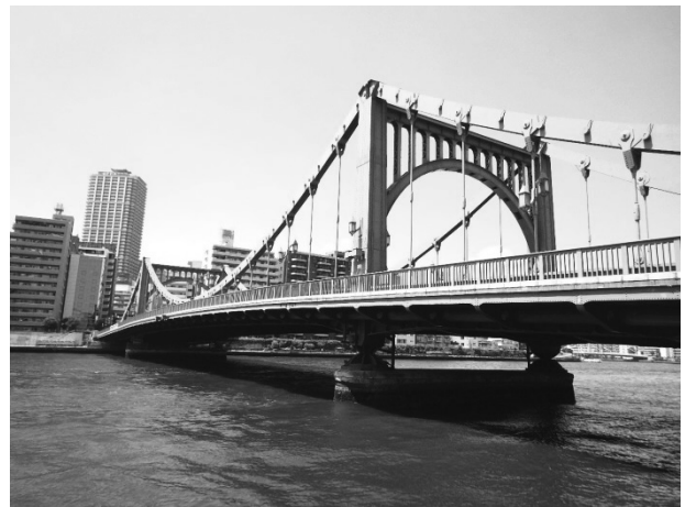
図-1 清洲橋全景
