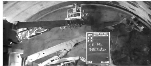
図-4 鋼アーチ支保工建込み状況
