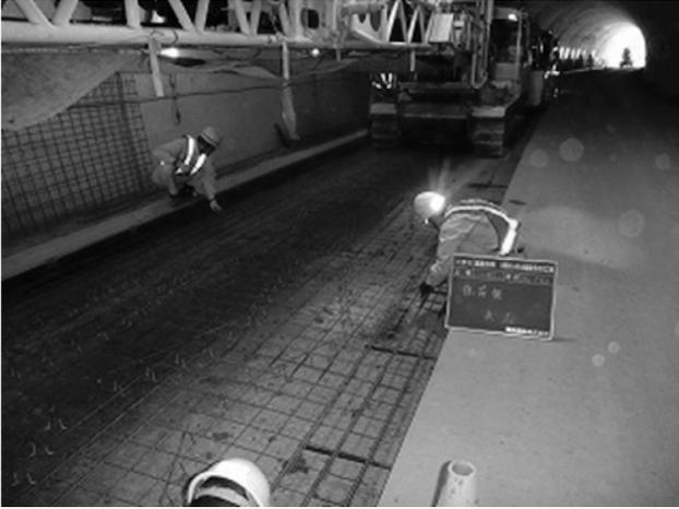
図-2 鉄網設置作業との並行作業状況
