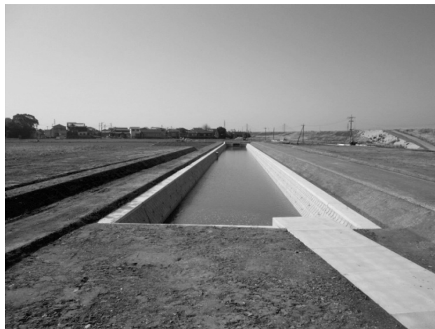
図-2 水路工完了
