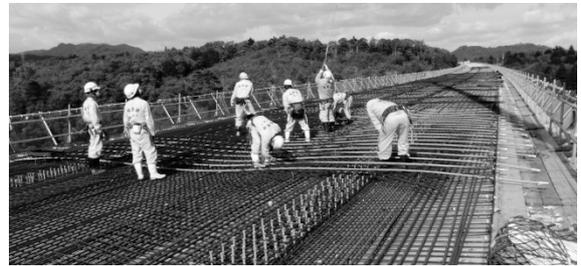
図-1 羽黒川橋着手時の状況（鉄筋、型枠撤去）
