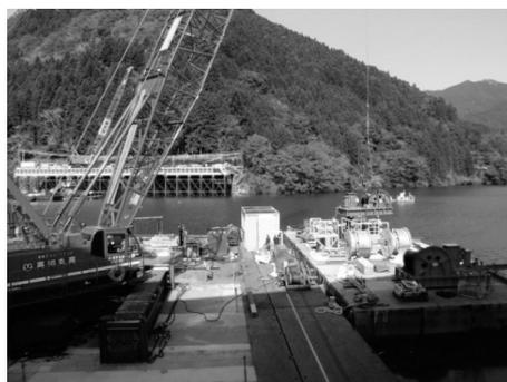
図-1 6号開閉装置吊り込
