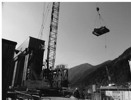
図-2 1号開閉装置吊り込
