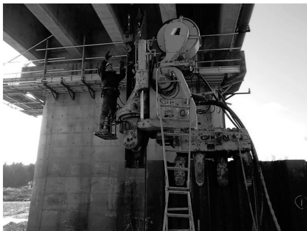
図-2 シートパイル施工状況
