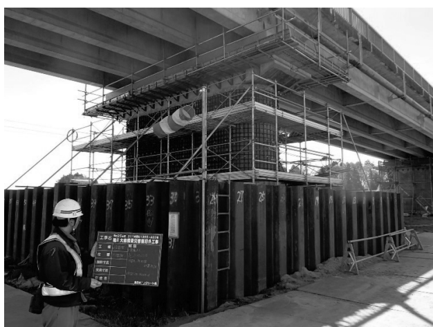
図-3 Iq システムを使用した作業足場
