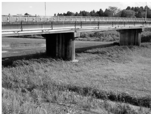
図-1 粕川大橋巻き立て施工前
