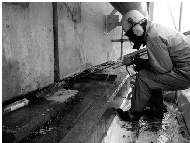
図-4 沓交換作業状況
