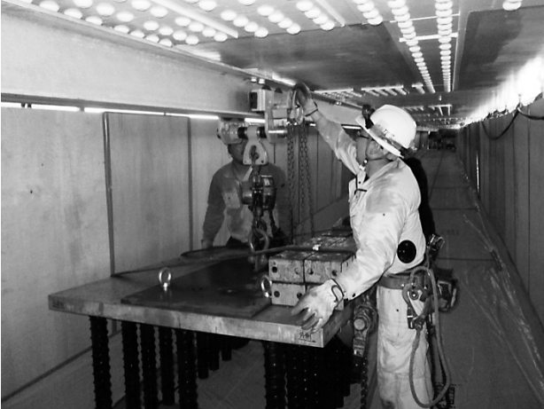
図-2 運搬レール設備
