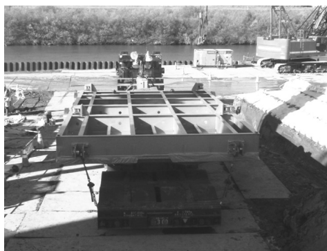
図-3 現場搬入時
