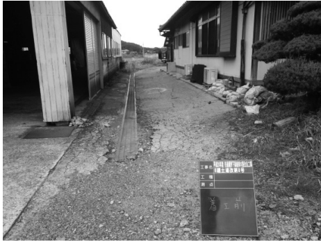
図-2 施工箇所状況
