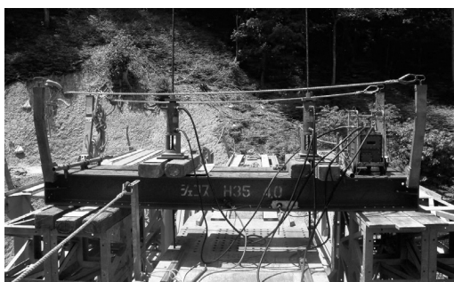
図-6 仮設吊り装置
