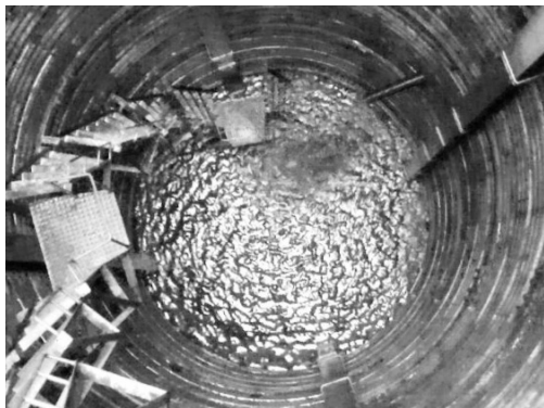
図-1 着工前状況 静水槽天端が水没している
