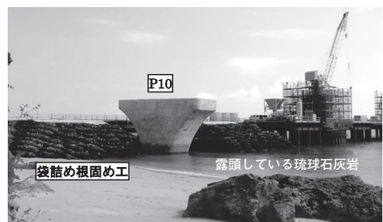
図-4 施工完了全景
