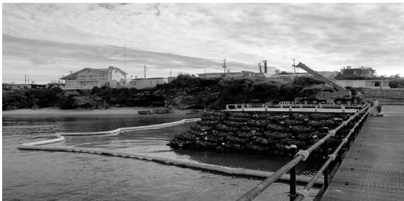
図-3 袋詰め根固め工法の施工状況
