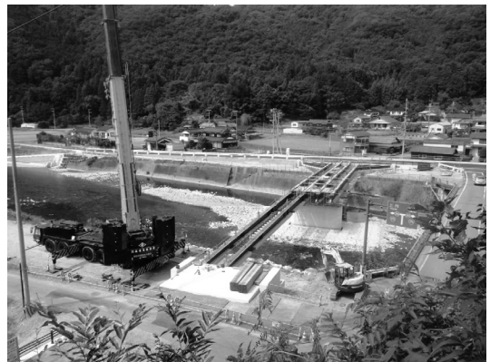
図-6 360tクレーンによる架設状況
