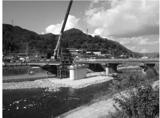
図-5 河川内ベント設置状況
