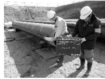
図-4 砂礫混入防止対策
