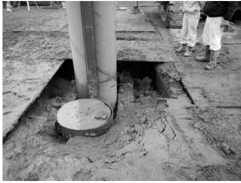
図-3 布堀箇所土砂流出
