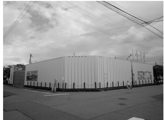
図-4 発進立坑ヤード仮囲い工
