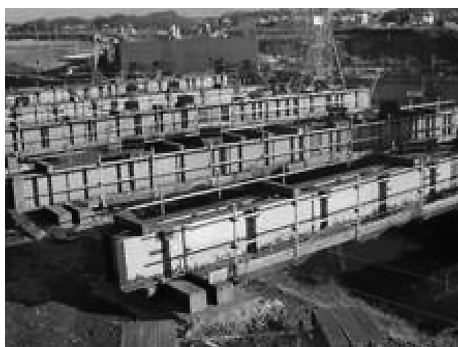
図-4 大梁ベント設備
