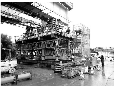
図-3 ジャッキアップ・ダウン用ベント(P10)と作業状況
