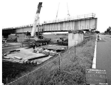
図-2 堤防道路（P12-P13側径間架設中）
