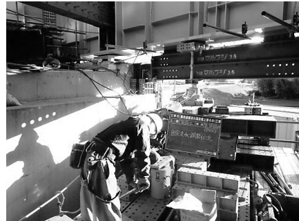
図-5 固定支承の位置調整状況
