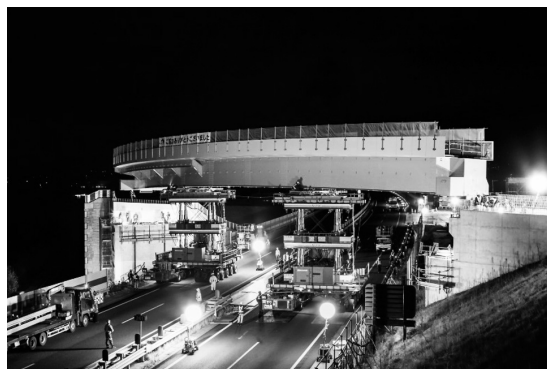
図-3 A2ランプ橋夜間架設
