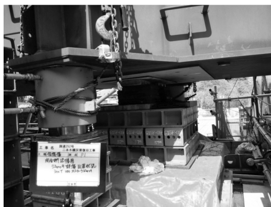
図-3 P1、P2橋脚支承高の上げ越し
