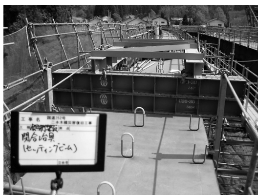
図-4 閉合ブロック調整治具
