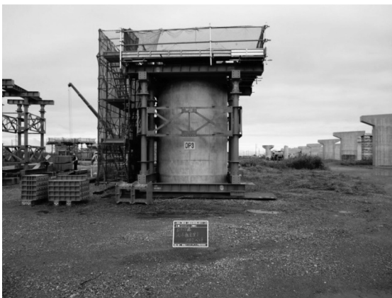
図-4 脚回りベント設備
