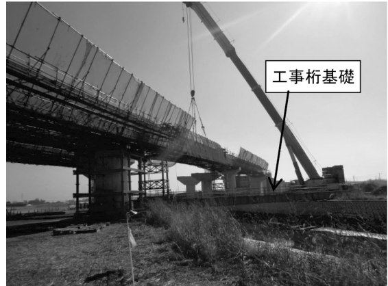
図-5 工事桁基礎ベント構造
