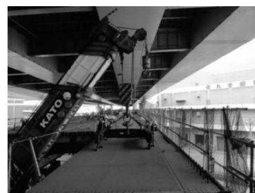
図-8 上空制限下での架設状況
