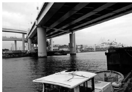
図-2 本牧5号橋架設位置（架設前）
