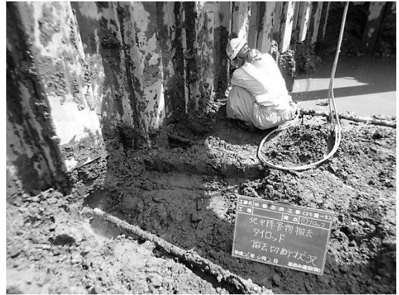
図-5 タイロッド切断状況
