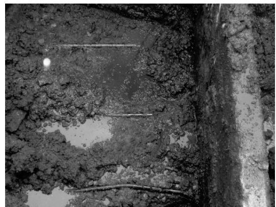
図-2 障害物（擁壁・タイロッド）
