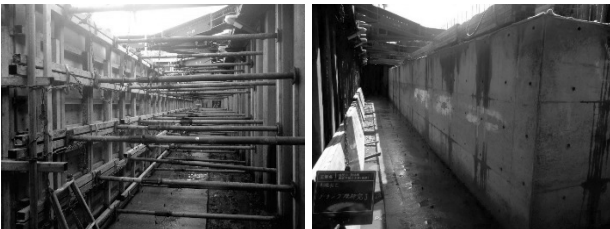
図-4 フーチング型枠及び完了
