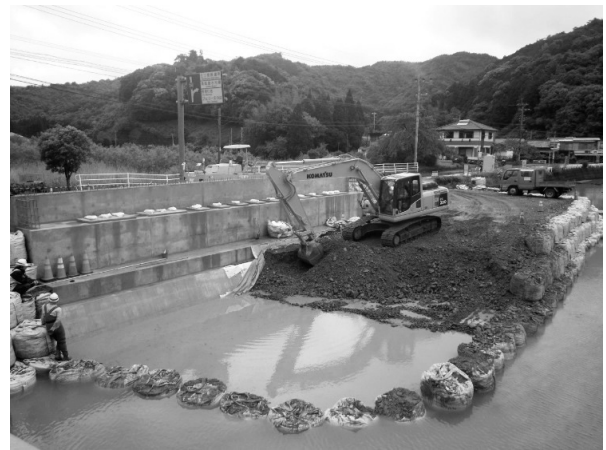
図-7 前面保護工土砂撤去状況
