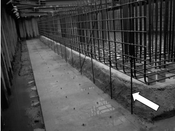
図-3 フーチング鉄筋組立完了
