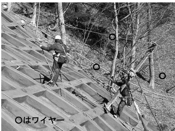
図-3 SD工法 (本現場施工状況)
