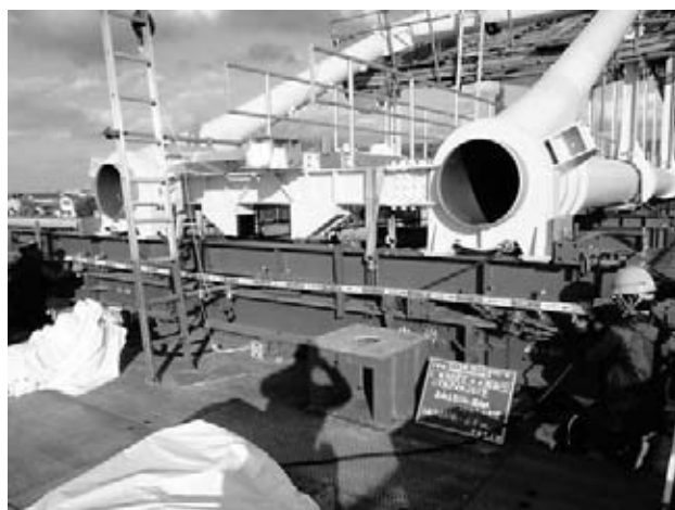
図-10 アウトリガーによる支持幅の延長
