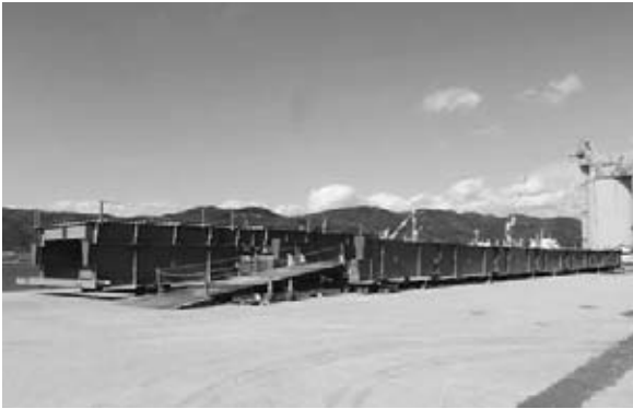
図-7 全橋組立て風景
