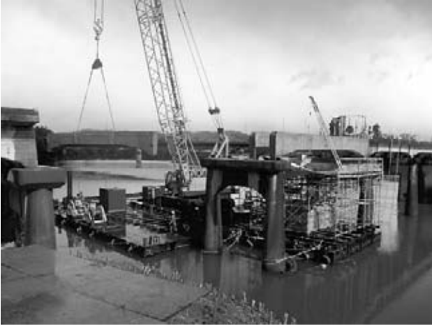
図-7 台船による撤去状況
