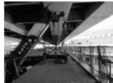
図-8 上空制限下での架設状況
