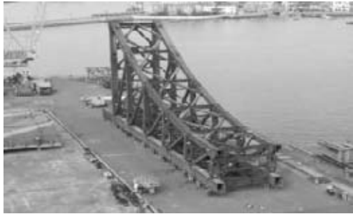
図-6 立体仮組立
