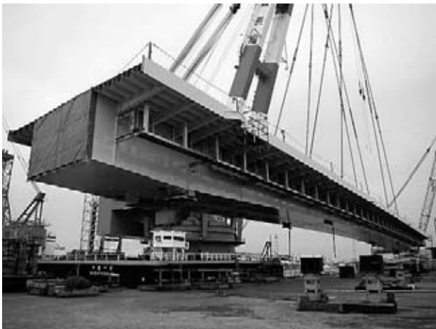
図-3 桁浜出し状況
