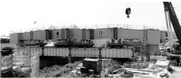
図-6 横梁架設完了
