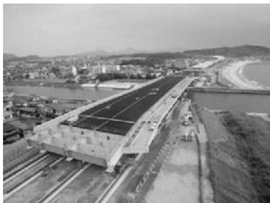
図-1 綾羅木川橋送出し状況
