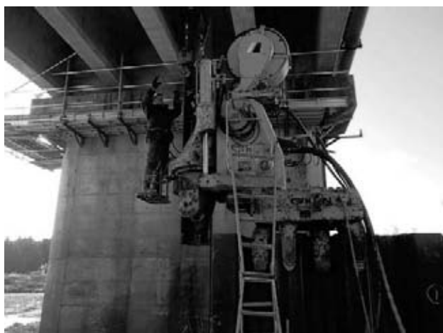
図-2 シートパイル施工状況
