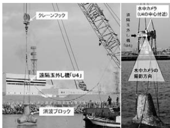
図-4 消波ブロック据付状況
