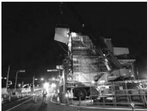
図-3 梁の夜間架設状況
