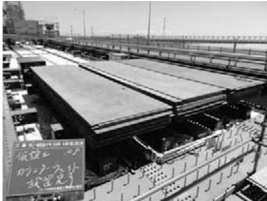
図-6 カウンターウェイト設置状況
