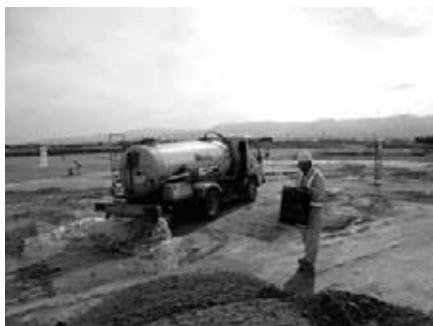
図-1 散水による含水比調整
