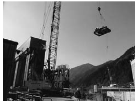
図-2 1号開閉装置吊り込
