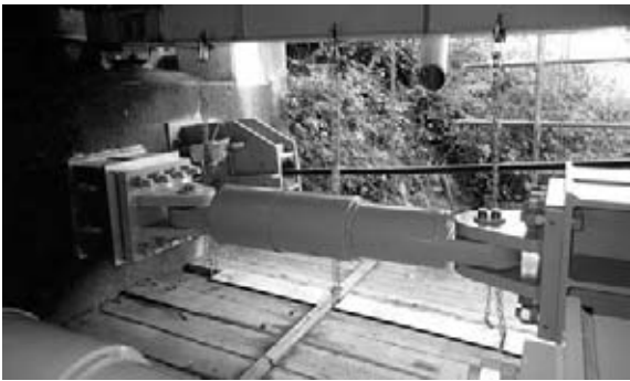
図-7 制震ダンパー設置完了
