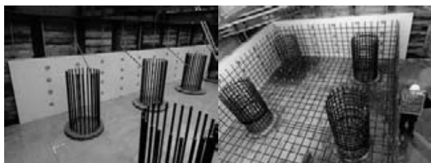
図-3 埋設型枠設置状況
