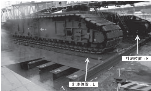
図-8 沈下観察状況
