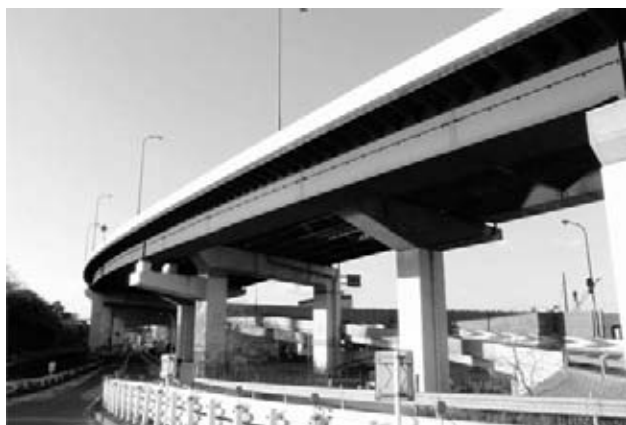
図-2 【施工前】既設入路ランプ橋
