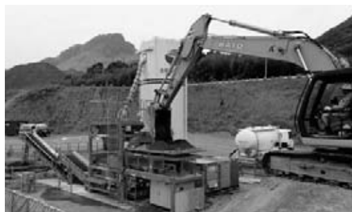
図-3 INSEM 材製造専用攪拌機 (作業状況)
