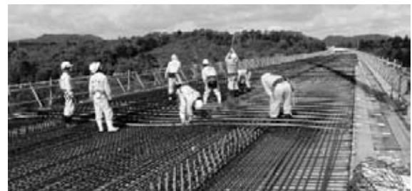
図-1 羽黒川橋着手時の状況（鉄筋、型枠撤去）
