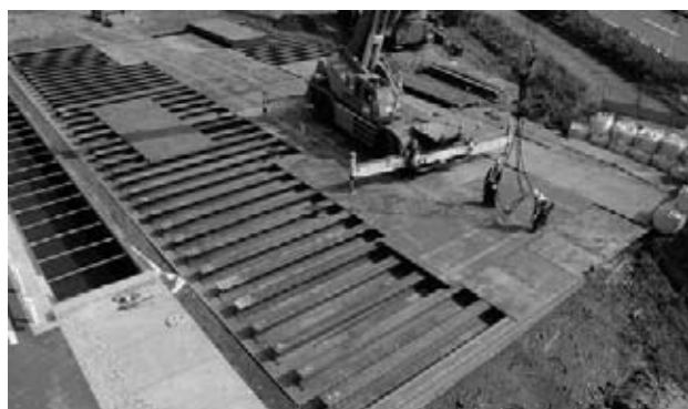
図-7 クレーン構台組立状況
