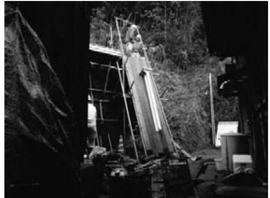
図-5 桷を使用した搬入状況
