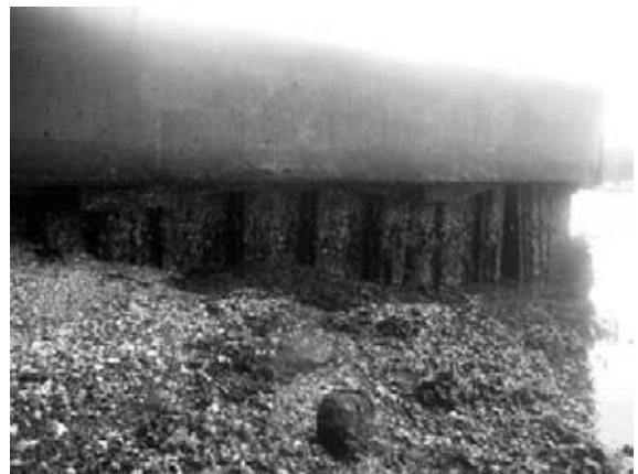
図-1 追の浜防波堤被覆防食施工前
