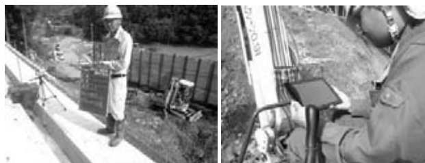
図-3 ビデオカメラ・タブレットを使用した掘削状況
