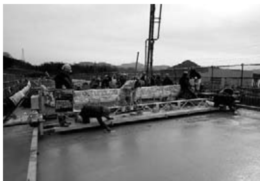
図-4 フィニッシャーによる締固め
