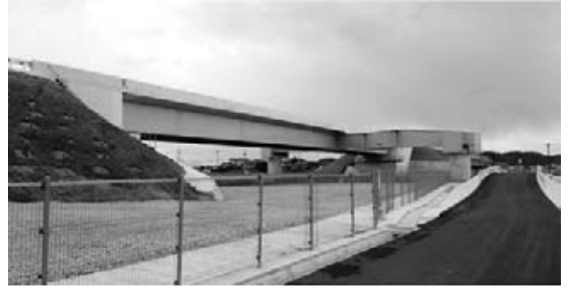
図-11 起点より終点を望む
