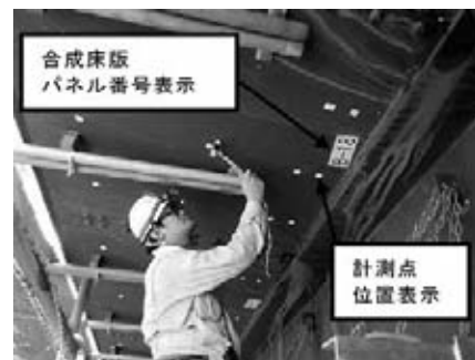
図-5 検査状況 (張出部)
