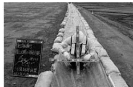
図-3 盛土天端土側溝
