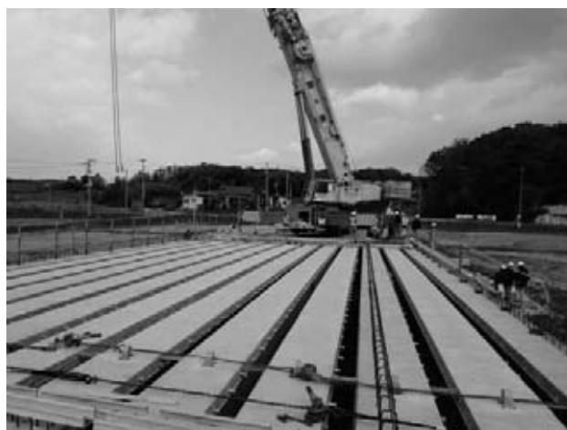
図-4 主桁架設完了（N=13本）
