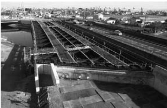
図-1 南陽橋全景写真（架設完了後）
