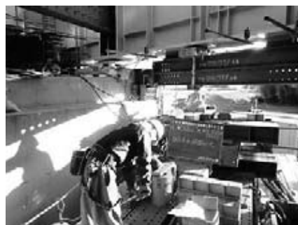
図-5 固定支承の位置調整状況
