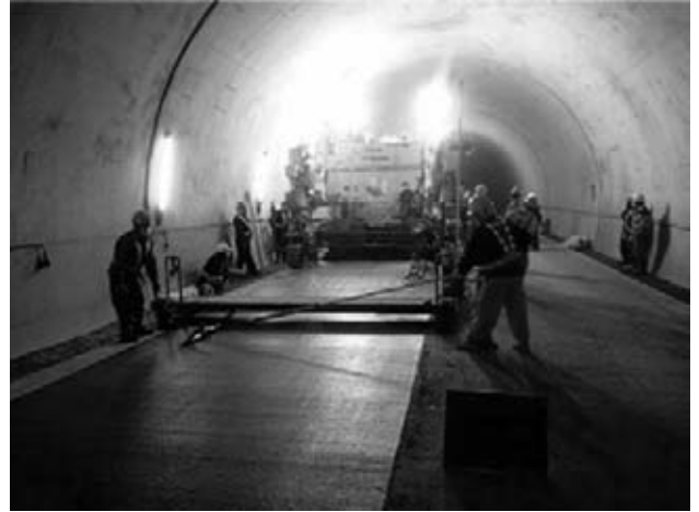
図-4 スリップフォーム工法による施工状況
