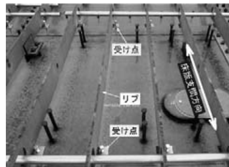
図-8 合成床版の内部鋼材
