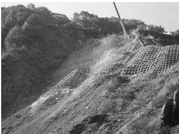
図-2 法面工 施工状況
