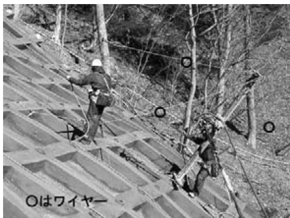
図-3 SD 工法 (本現場施工状況)
