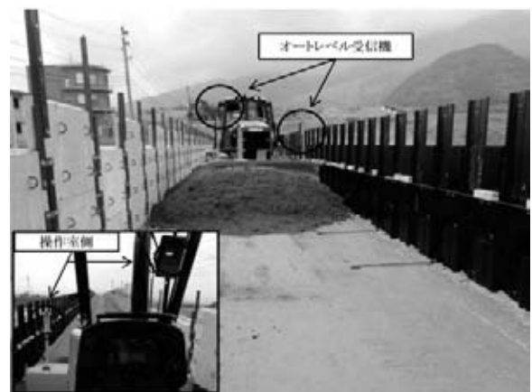
図-5 オートレベル使用状況
