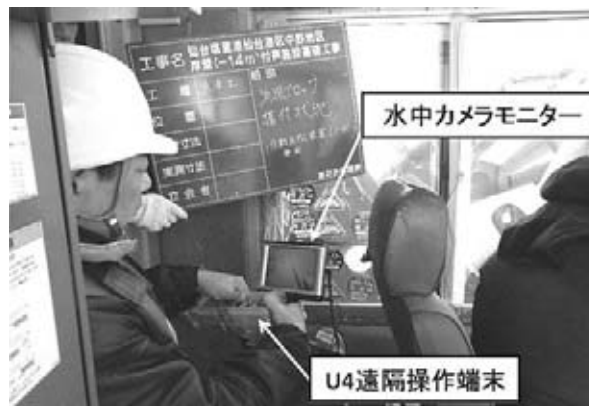
図-5 水中カメラでの玉外し状況確認
