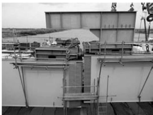
図-4 閉合前の仕口変形状況
