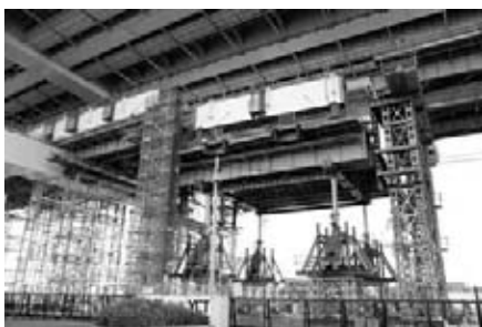
図-2 地組み桁リフトアップ状況
