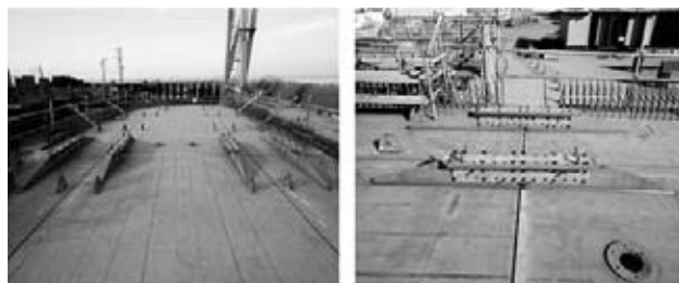
図-7 バイパス材取付状況
