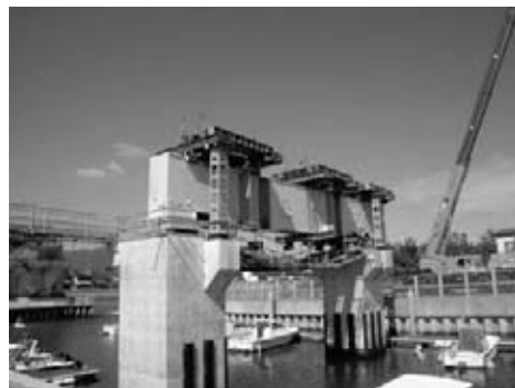
図-9 横梁を利用した基礎設置状況
