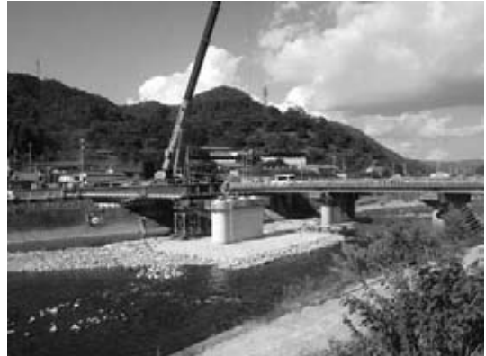
図-5 河川内ベント設置状況
