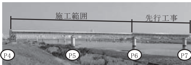
図-1 工事完了写真(施工範囲)
