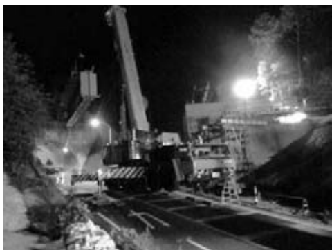
図-2 BラインP3～A2夜間架設
