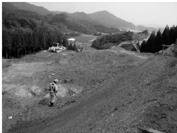
図-2 切土法尻部測定状況
