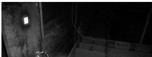
図-3 土留頭部変位計測位置（シートプリズム）
