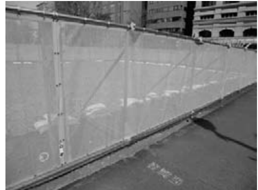
図-4 4か月後の仮囲い状態
