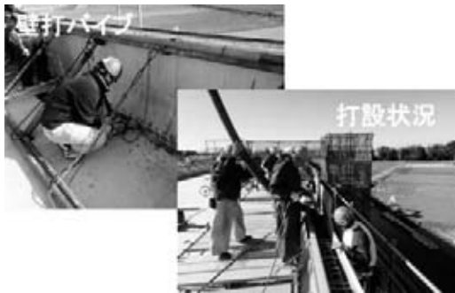
図-9 埋設型枠打設状況
