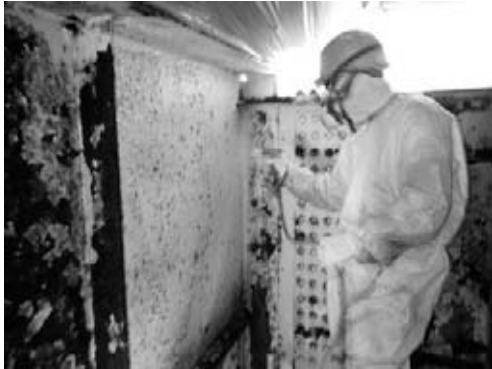
図-3 剥離剤塗布状況
