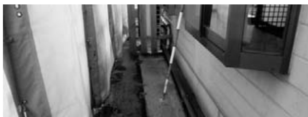
図-4 沈下計測位置（鉄釘）
