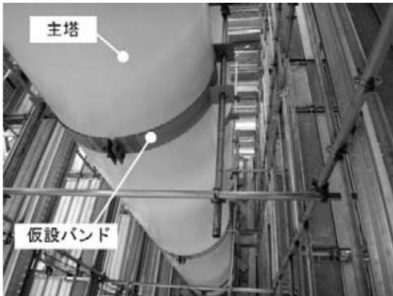
図-6 主塔と架設足場をつなぐ仮設バンド
