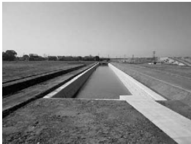
図-2 水路工完了
