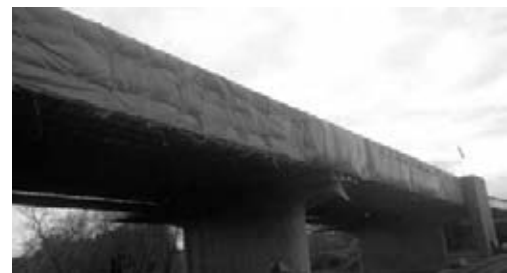
図-5 現場塗装養生状況
