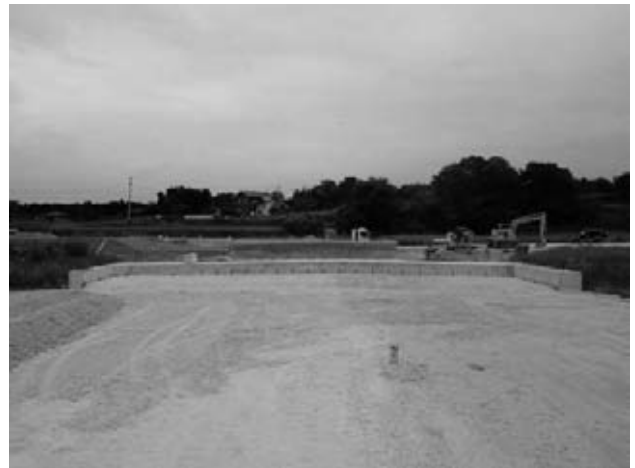
図-1 工事着手前
