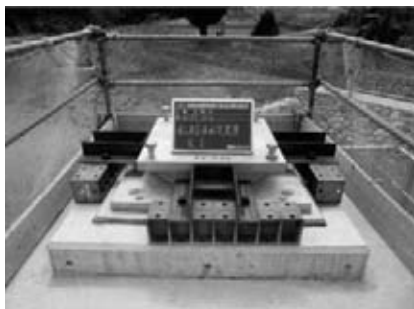
図-9 P1橋脚固定装置
