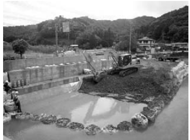
図-7 前面保護工土砂撤去状況
