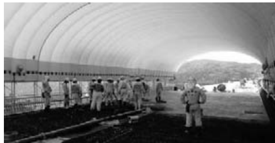
図-6 エアドームによる雨天対策
