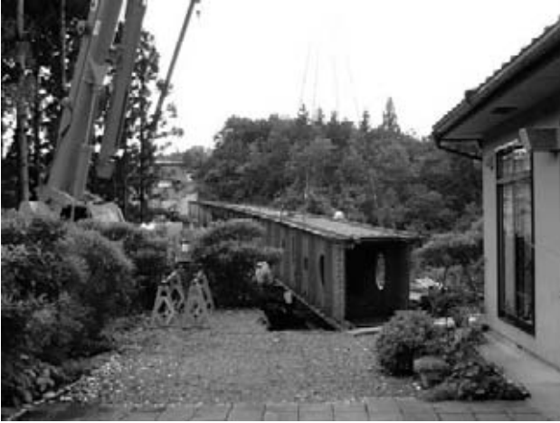
図-2 架設桁組立状況
