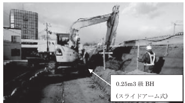
図-4 仮設重機足場上での作業状況
