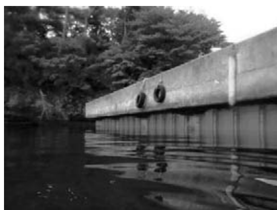
図-11 追の浜（B）防波堤被覆防食完成
