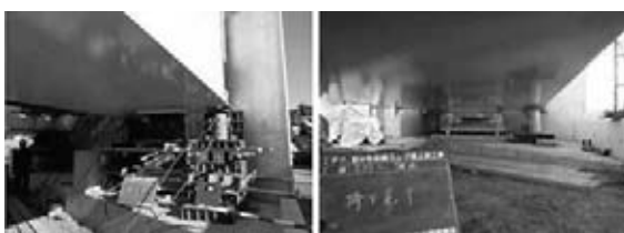
図-3 降下作業 (左:降下前、右:下降後)
