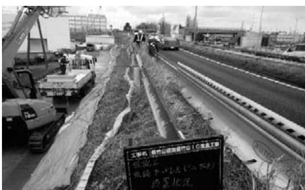
図-6 仮設ガードレール設置状況
