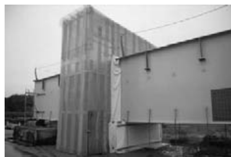
図-5 地組立状況
