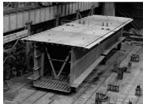
図-8 大ブロック継手の確認状況
