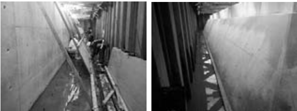
図-5 前面保護工型枠建込・前面保護工完了 前面保護工完了後、山留材を撤去する為に、土
