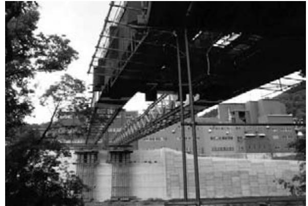
図-2 送り出し架設状況
