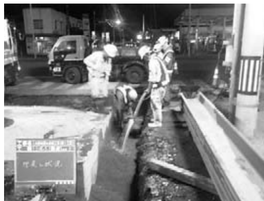
図-4 埋戻し状況
