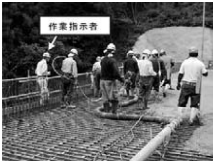
図-4 コンクリート打込み状況
