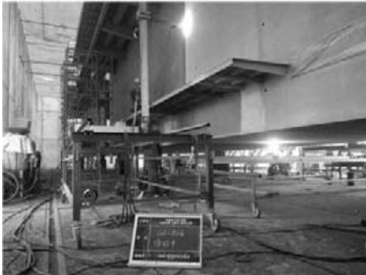
図-6 自動溶射状況
