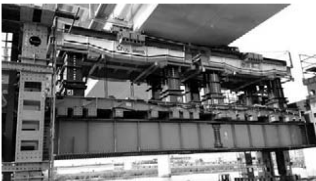
図-6 デッキリフト降上状況
