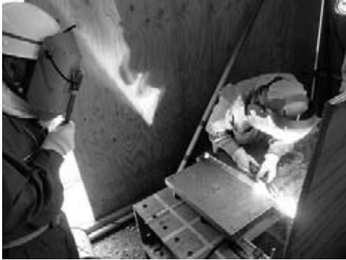
図-10 溶接技量試験実施状況
