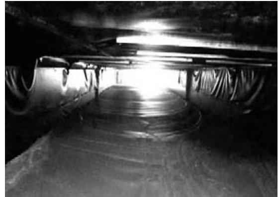
図-4 ボックス内充填状況
