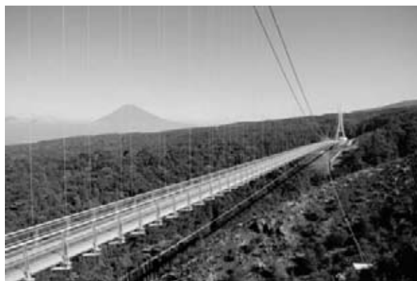
図-1 箱根西麓・三島大吊橋
