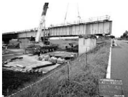
図-2 堤防道路（P12-P13側径間架設中）
