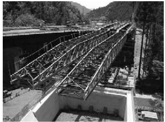
図-1 送出し架設状況
