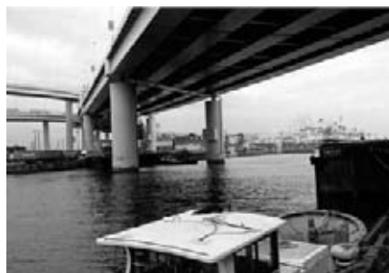
図-2 本牧5号橋架設位置（架設前）
