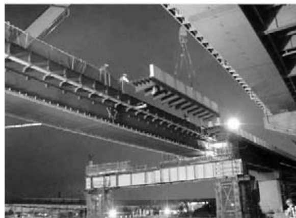
図-7 既設入路ランプ橋の解体
