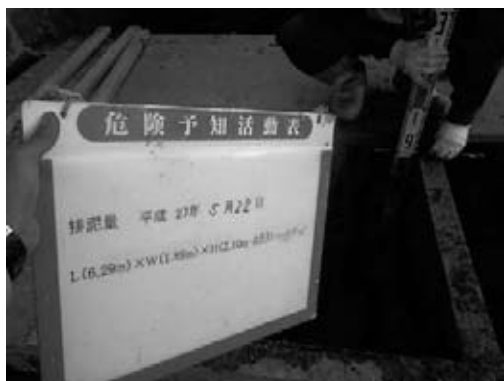
図-3 排泥量の測定
