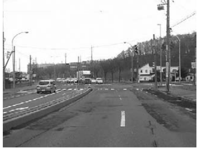
図-10 作業前L側 (2012.3)
