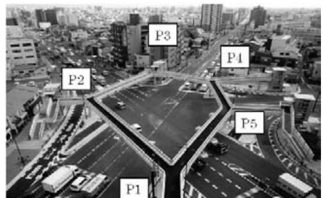
図-1 架け替え後の杭全横断歩道橋
