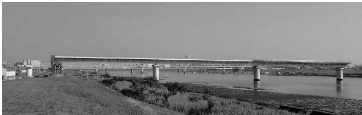
図-5 工事完成状況
