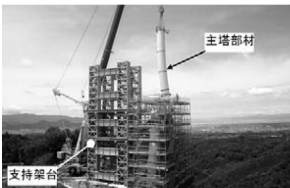
図-7 3P主塔の架設状況
