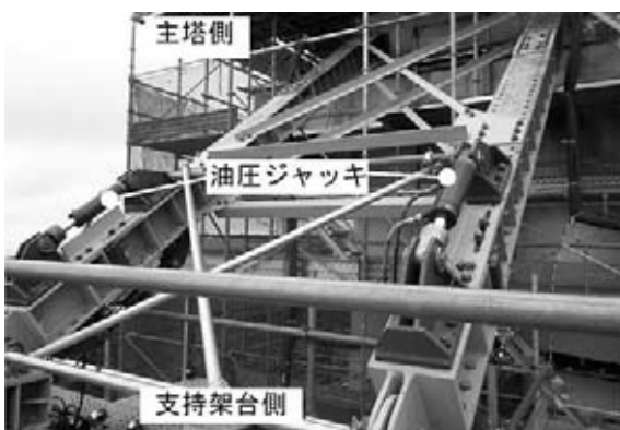
図-8 主塔と支持架台をつなぐ連結部材
