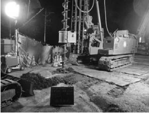
図-3 親杭打設施工状況
