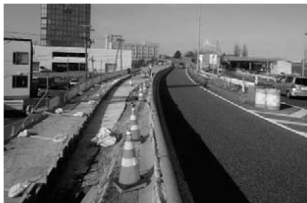
図-7 仮設ガードレール設置完了
