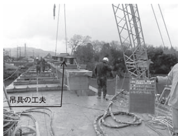
図-6 床版・横桁の一括撤去
