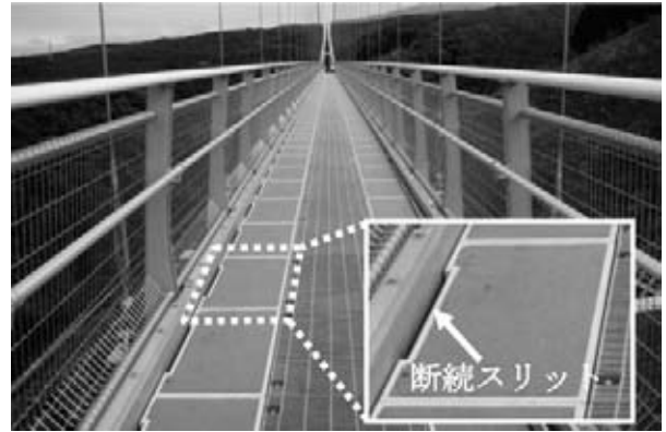
図-11 プレキャストRC床版のスリット構造
