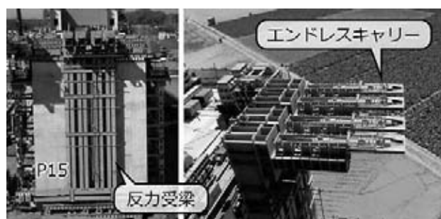
図-7 エンドレスキャリー設置状況
