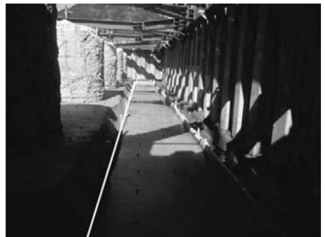
図-2 均しコン打設完了 (杭通りがフーチング外面より15cm内通り)
