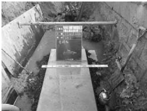
図-4 基礎板施工状況
