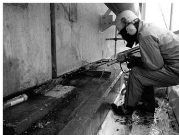
図-4 沓交換作業状況
