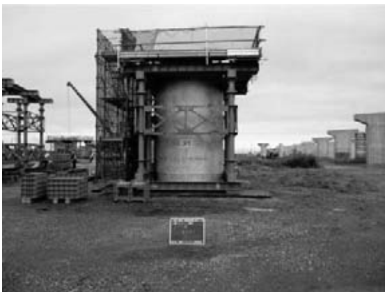
図-4 脚回りベント設備
