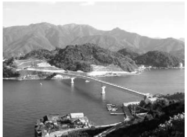
図-2 完成写真（九島より撮影）
