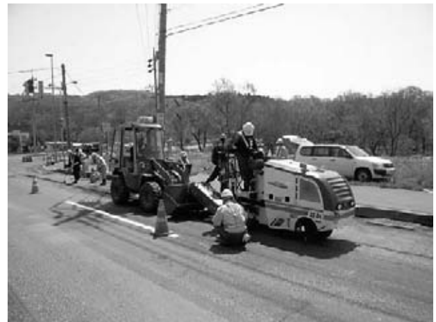
図-7 クラック部溝切削状況
