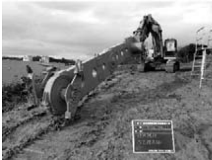
図-2 ベースマシン1.4m 3 バックホー
