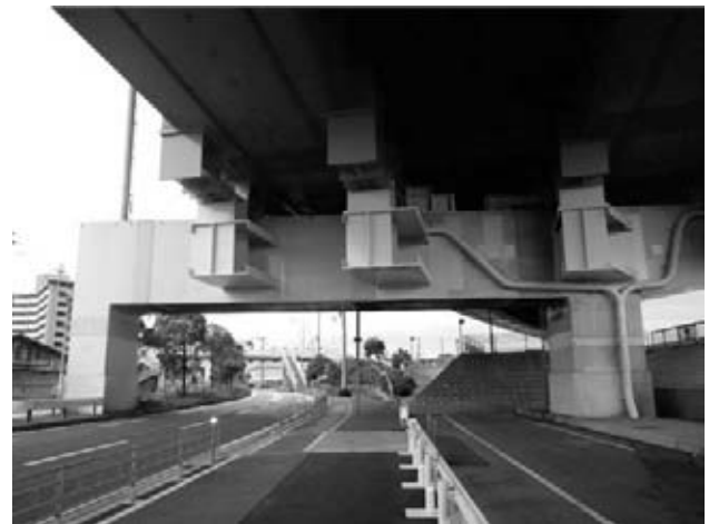
図-7 平林高架橋 P111の施工完了後状況
