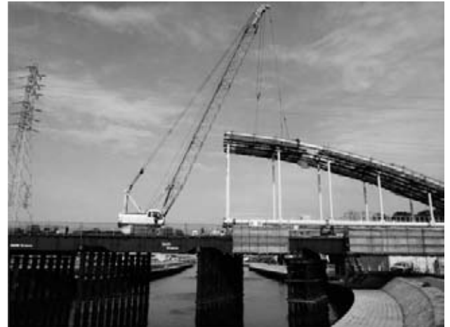
図-7 アーチリブの面組架設と足場設置
