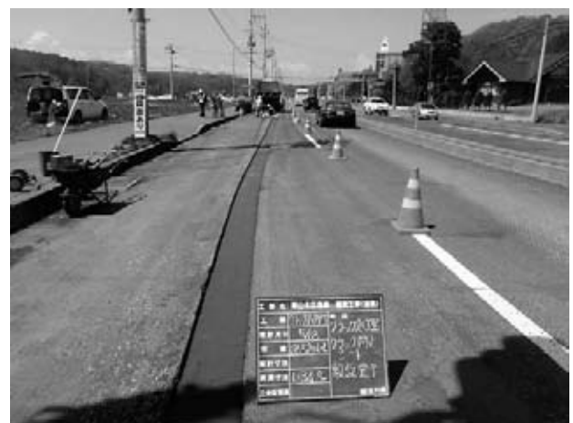
図-8 クラックシート設置状況
