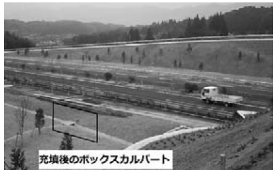
図-5 ボックス充填後の完成全景
