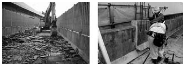
図-6 舗装撤去・壁高欄コンクリート撤去
