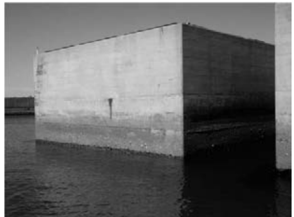
図-1 使用ケーソン全景
