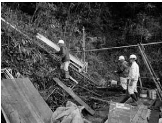
図-4 落石防護柵の搬入状況
