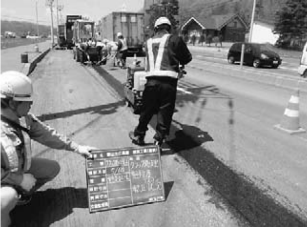
図-9 基層舗装状況
