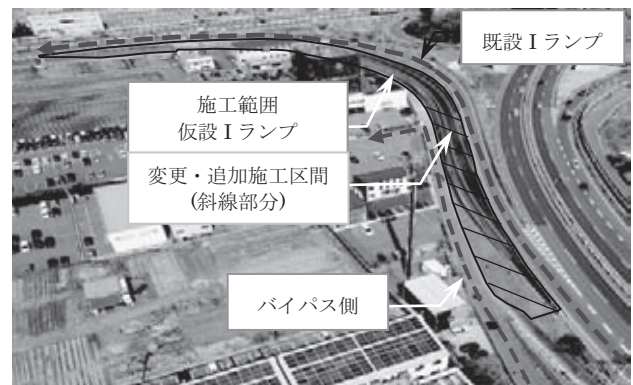
図-1 仮設 I ランプ完成写真 までを行う。
