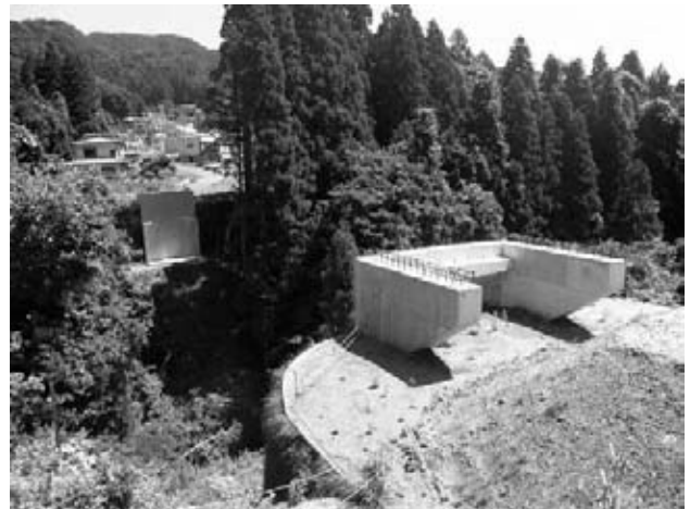
図-1 工事施工前
