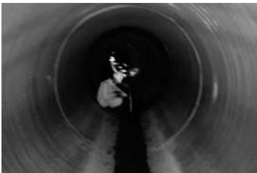
図-4 埋設管の内径を測定(目視調査)
