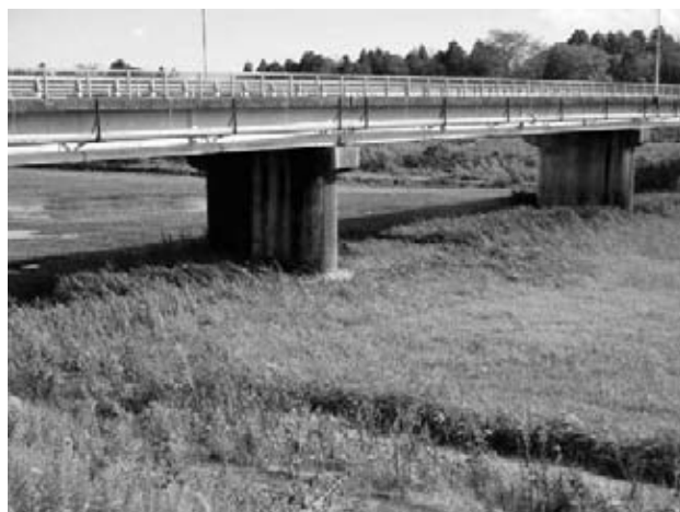
図-1 粕川大橋巻き立て施工前
