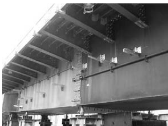
図-9 仮組立状況（右側が再利用桁）
