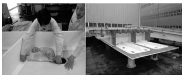
図-6 カバ- PL 実物大模型再検証と桁取付状況
