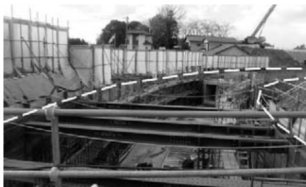
図-6 山留支保工架設状況
