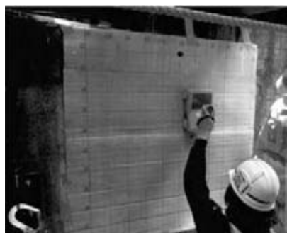
図-2 鉄筋探査作業
