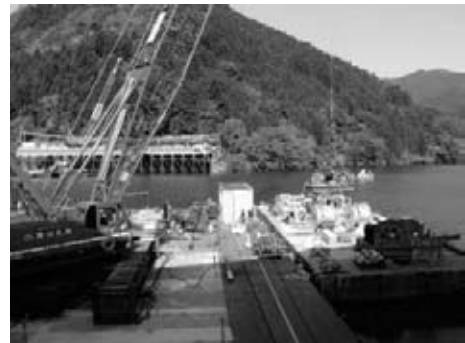
図-1 6号開閉装置吊り込
