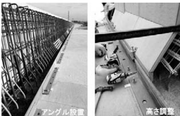
図-7 内型枠の設置
