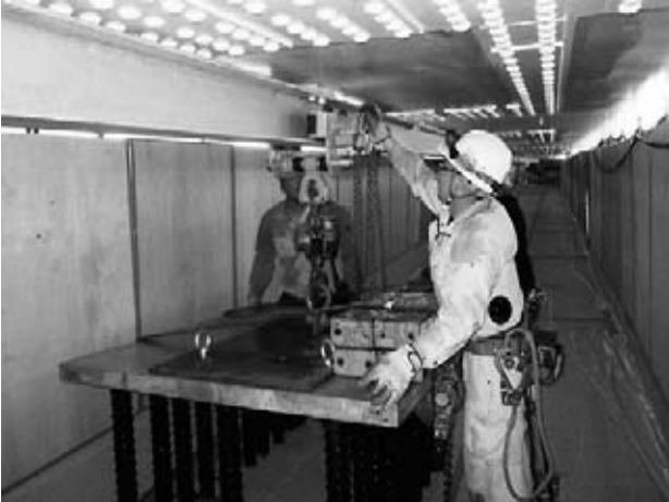
図-2 運搬レール設備
