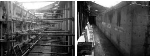
図-4 フーチング型枠及び完了
