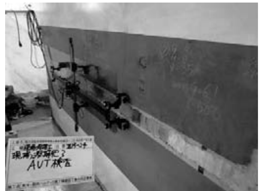
図-12 超音波自動探傷検査状況
