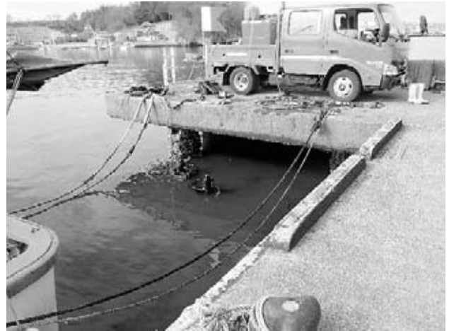
図-4 事前調査作業状況
