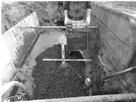
図-3 湧水処理状況
