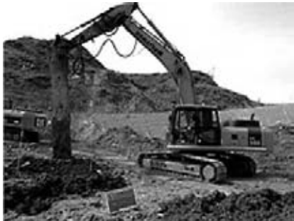
図-3 地盤改良施工状況
