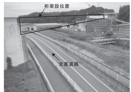
図-2 交差道路状況
