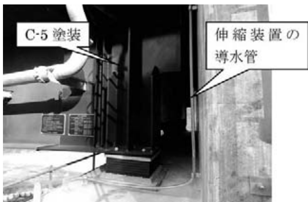
図-2 外面塗装・伸縮装置導水管
