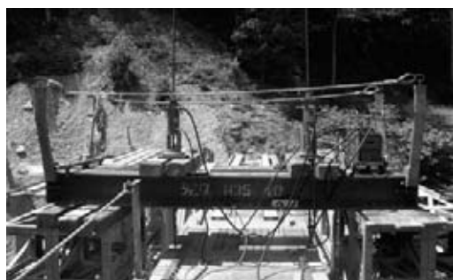
図-6 仮設吊り装置
