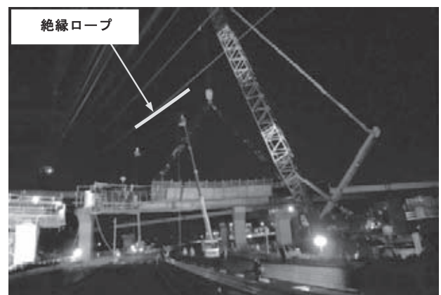
図-3 高所作業車による接近限界ロープ設置状況
