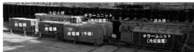
図-9 パイプクーリング循環設備
