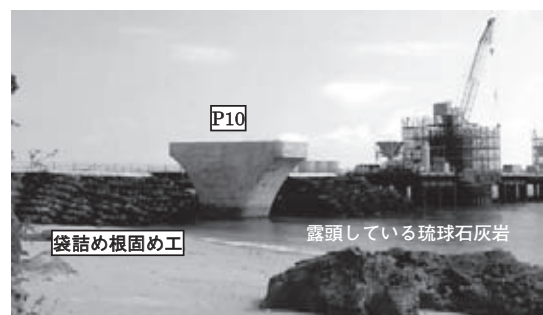
図-4 施工完了全景
