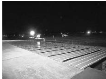
図-6 本施工状況写真
