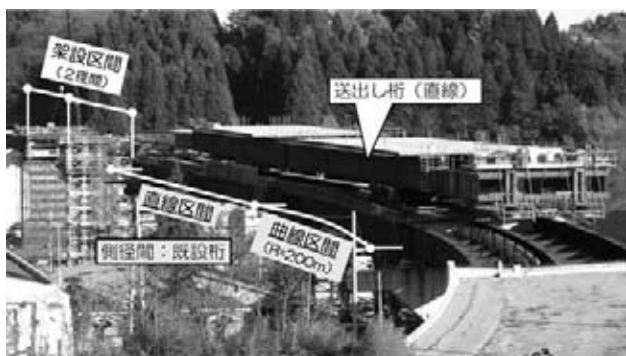
図-1 送出し架設状況
