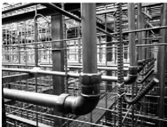
図-8 パイプクーリング配置状況
