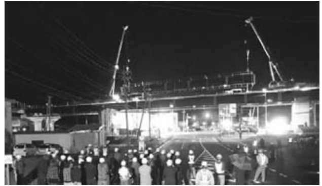
図-6 相吊り架設
