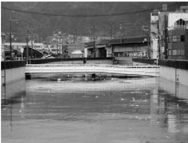
図-1 現三箇大橋増水時の状況
