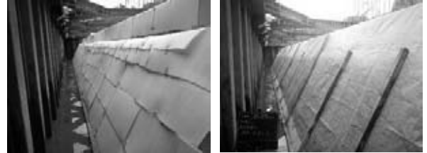
図-6 梱包用衝撃吸収材設置・ブルーシート設置完了
