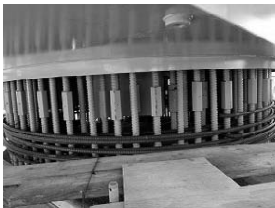
図-2 AP1剛結部鉄筋挿入状況
