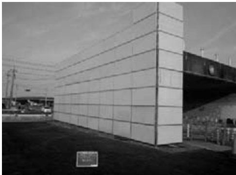
図-2 飛散養生設備（仮設足場）
