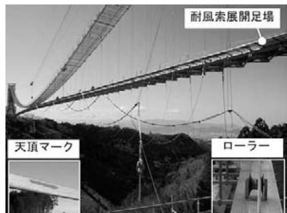
図-9 耐風索架設状況
