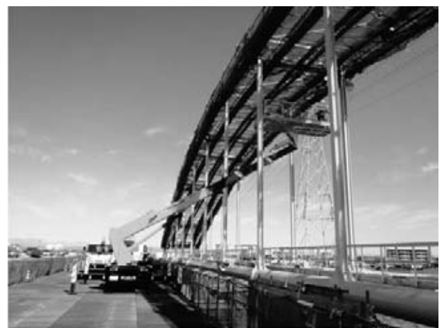
図-8 高所作業車による足場撤去
