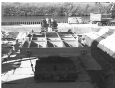
図-3 現場搬入時
