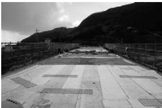
図-5 保水・保温養生マット敷設
