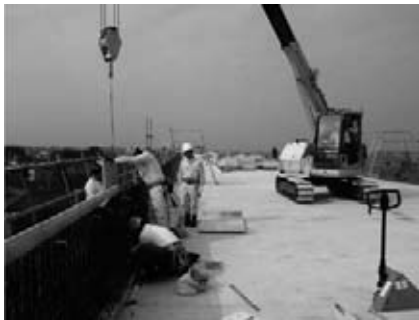
図-6 ミニクローラによる外型枠の設置
