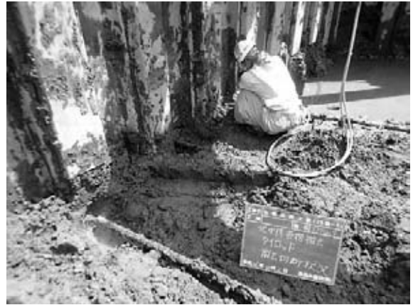
図-5 タイロッド切断状況
