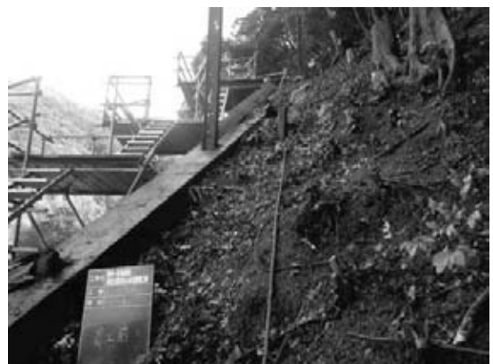
図-2 傾斜角46°の搬入路
