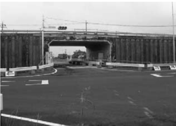
図-1 ボックスカルバート現況
