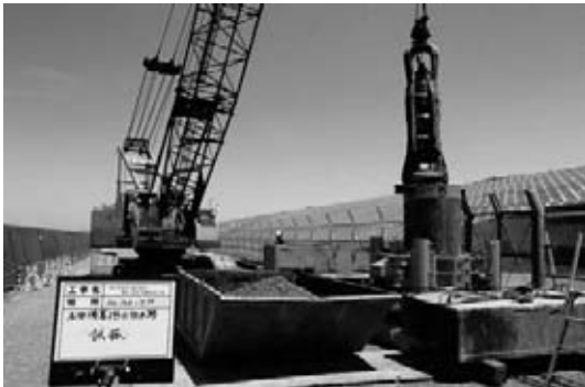
図-3 ケーシング立坑の設置(試掘調査)
