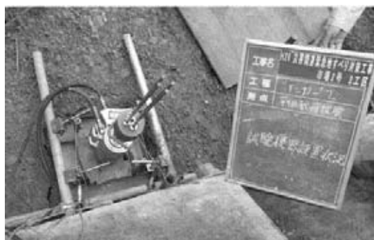
図-3 荷重試験装置の設置状況
