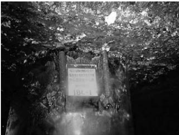
図-3 不要鋼材撤去前
