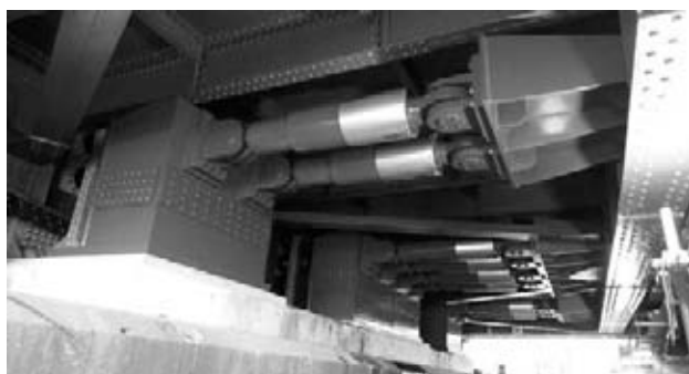
図-2 ダンパー設置完了
