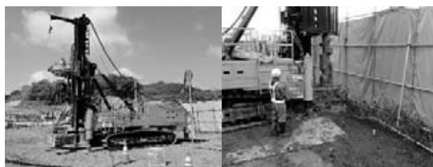
図-4 掘削機／施工状況
