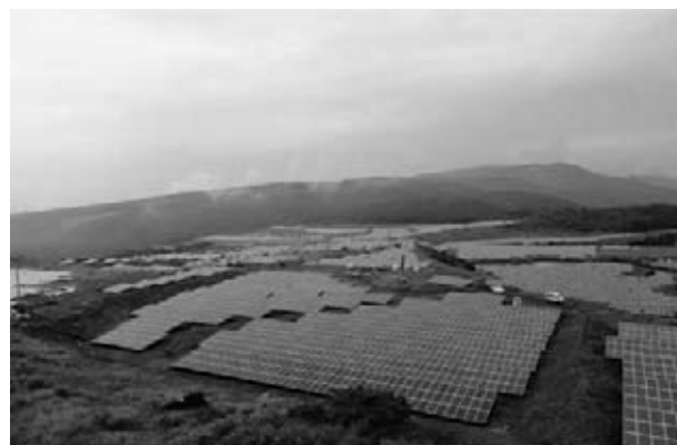
図-8 アレイ間隔無しコース 方向、勾配方向に逆らわない配置
