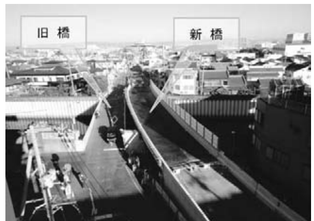
図-2 三箇大橋現況 H27.12現在（全景）
