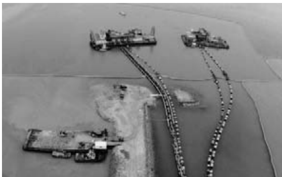
図-1 空気圧送状況 (写真左側が本工事で使用した圧送船)
