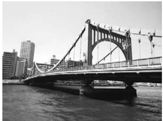
図-1 清洲橋全景
