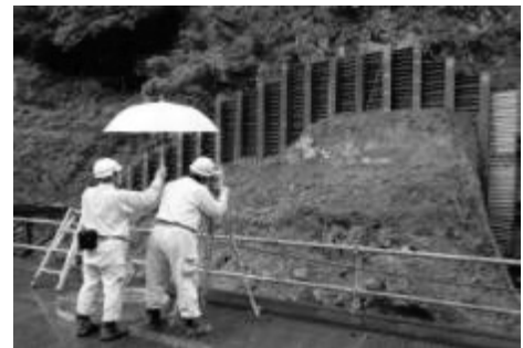
図-8 ノンプリズムトータルステーションを用いた測量状況
