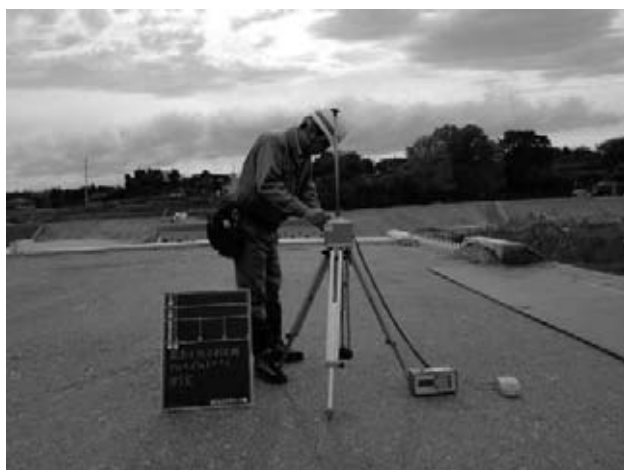
図-2 キャスポルによる地盤支持力測定状況
