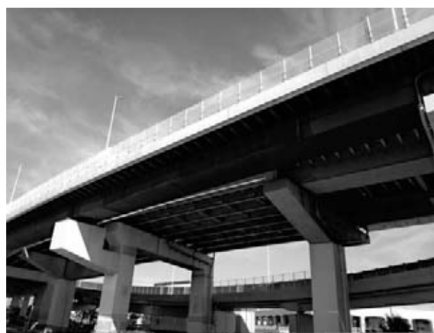
図-10 【施工後】再利用されたランプ橋
