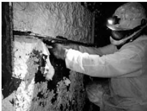
図-5 塗膜剥離除去作業
