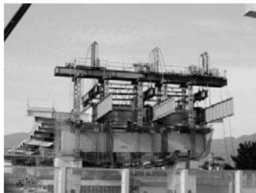
図-14 横梁を利用した降下設備設置状況
