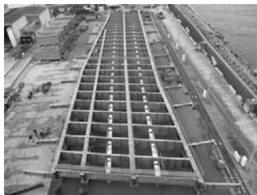
図-2 拡幅部の仮組立状況
