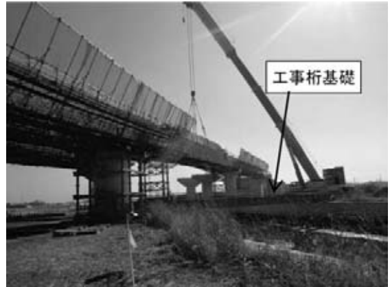
図-5 工事桁基礎ベント構造
