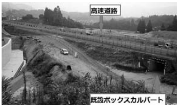
図-1 高速道路直下のボックスカルバート
