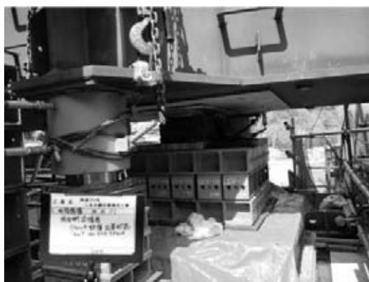
図-3 P1、P2橋脚支承高の上げ越し
