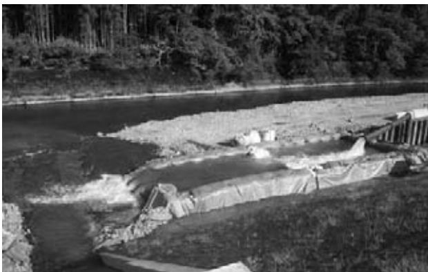
図-1 沈砂池設置
