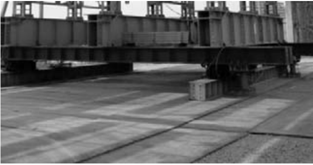
図-7 敷鉄板状況写真
