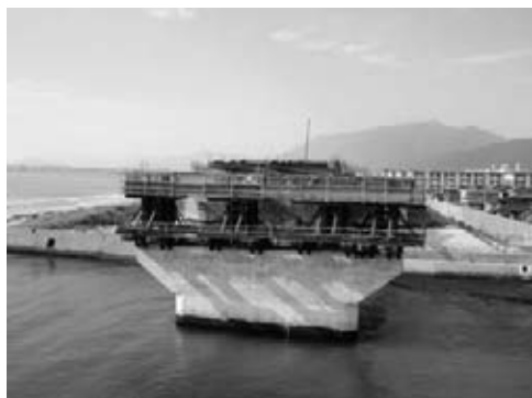
図-12 橋脚上送出し設備設置状況
