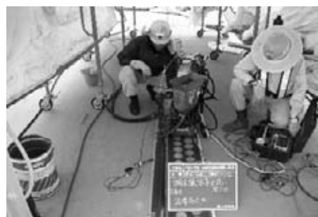
図-6 溶接施工時の状況
