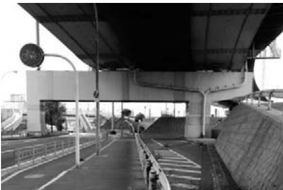
図-1 平林高架橋 P111の着工前状況
