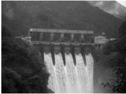
図-3 放流時の長安口ダム
