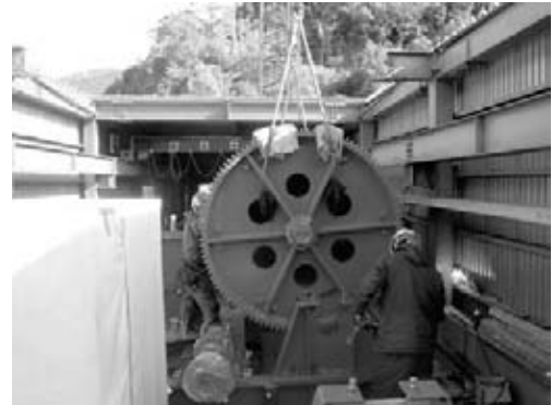
図-4 2号開閉装置組立て
