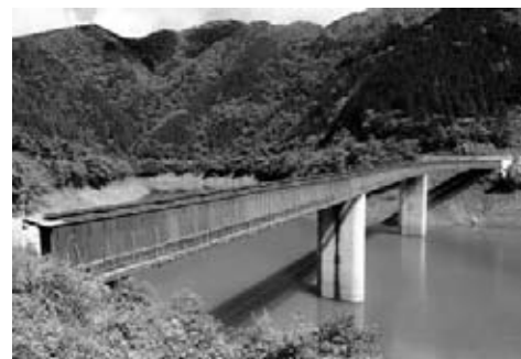
図-4 完了時全景(終点側・国道417号より)
