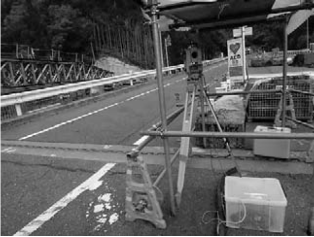
図-6 送出し桁先端位置測量状況
