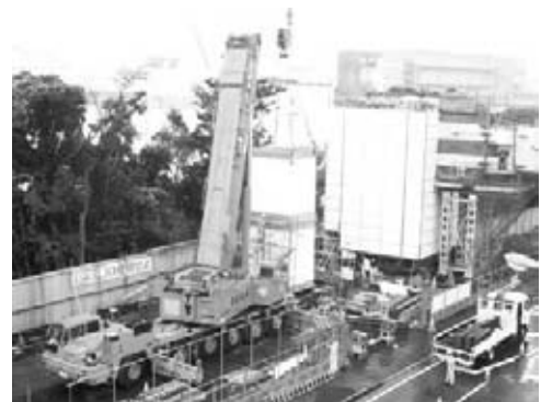
図-6 上層柱地組立て状況
