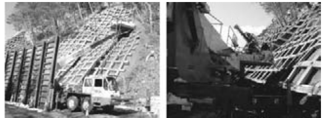
図-4 スカイステーションによる施工状況
