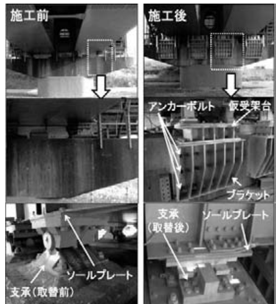
図-1 支承取替工事の概要
