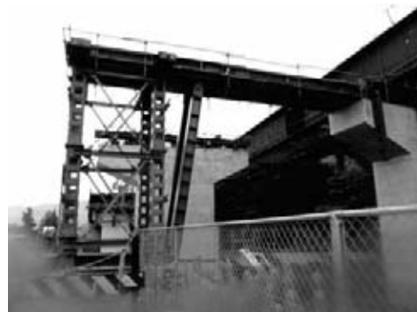
図-3 P2上Bライン横取り設備
