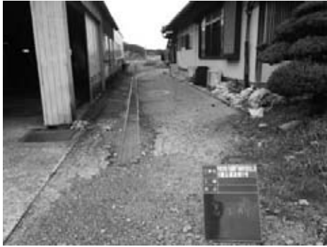
図-2 施工箇所状況
