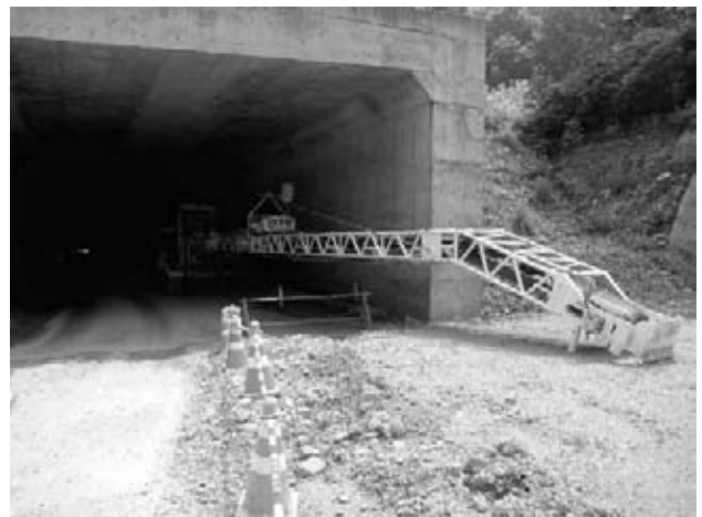
図-1 縦取機のベルコン
