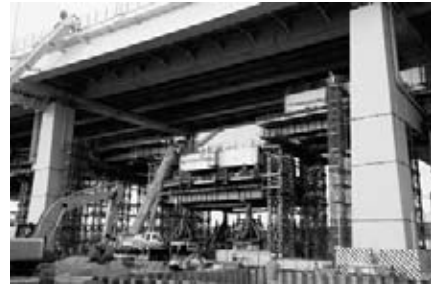
図-3 桁の荷揚げ地組み状況
