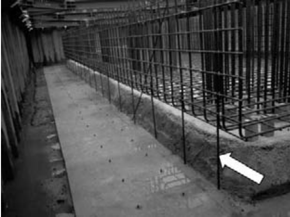
図-3 フーチング鉄筋組立完了
