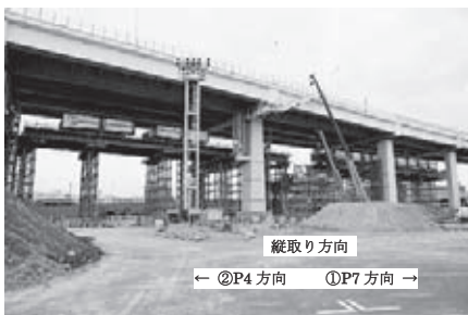
図-1 縦取り架設状況
