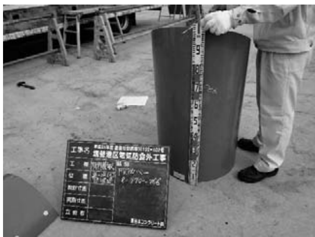
図-9 FRP カバー搬入
