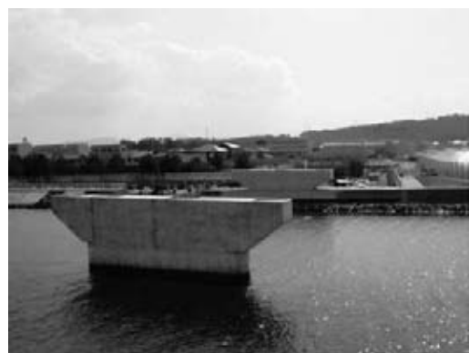
図-4 綾羅木川と渡河部の橋脚
