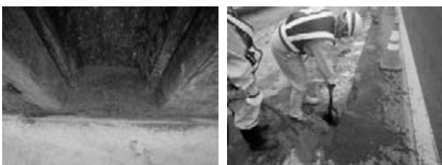
図-4 バイブレーターと水を併用した埋戻し
