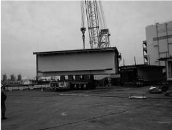
図-10 ユニットキャリアによる横持ち状況
