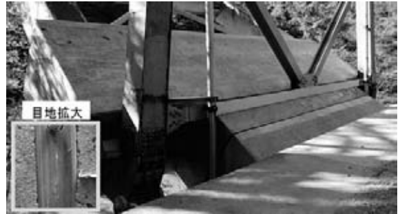
図-14 アーチ基部コンクリート施工完了
