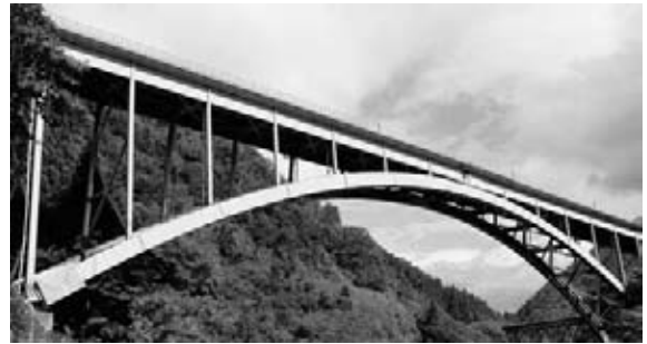
図-15 完成写真（左岸上流側より）
