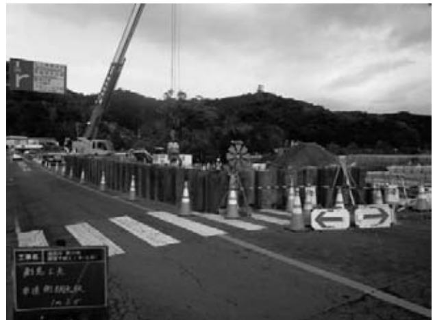
図-2 鋼矢板を利用した転落防止対策
