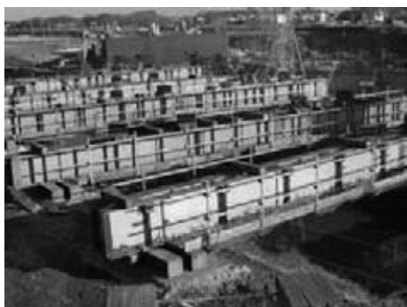
図-4 大梁ベント設備
