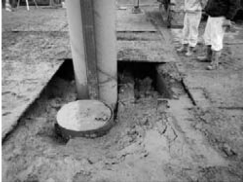
図-3 布堀箇所土砂流出
