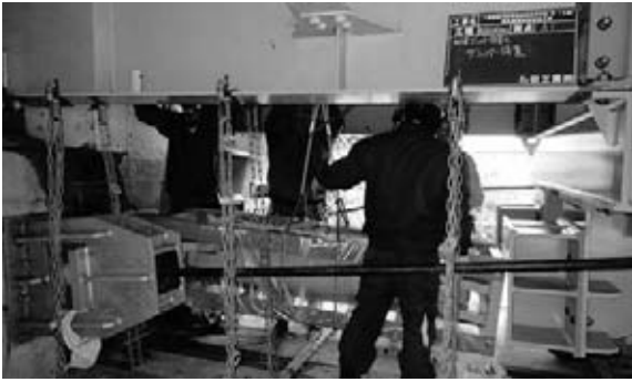
図-6 制震ダンパー設置状況
