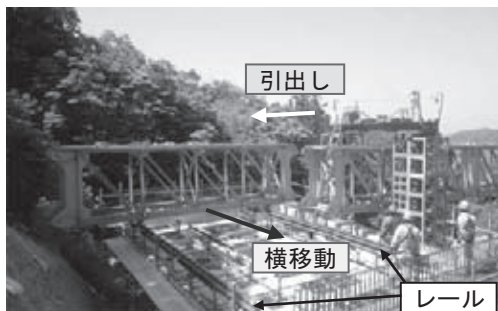
図-5 手延べ桁解体・横移動
