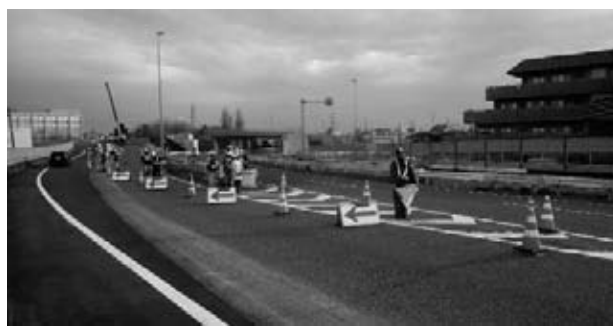
図-10 Iランプ切換直後の状況
