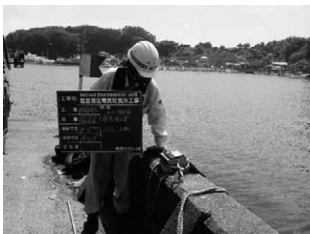
図-6 膜厚計による膜厚測定状況
