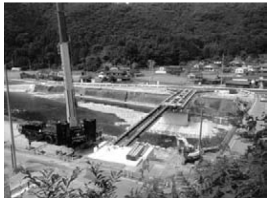
図-6 360t クレーンによる架設状況
