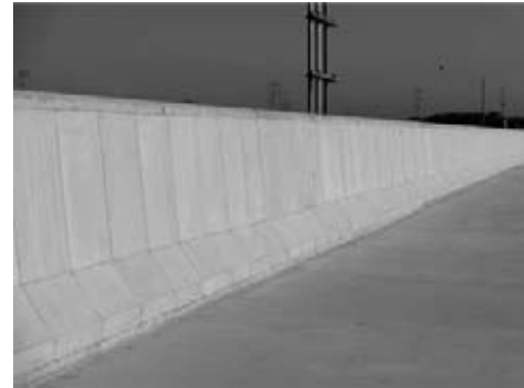
図-10 壁高欄施工完了
