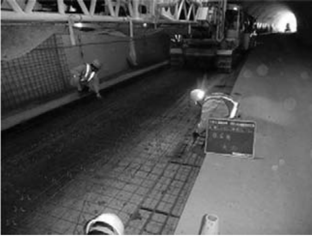
図-2 鉄網設置作業との並行作業状況
