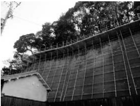
図-1 急傾斜地 高さ約20m
