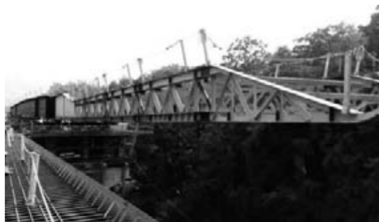
図-4 Aライン送出し、Bライン床版作業状況
