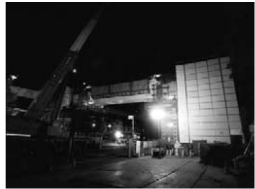
図-5 横梁一括架設状況
