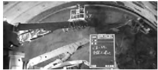
図-4 鋼アーチ支保工建込み状況
