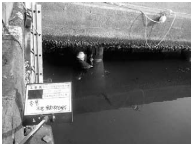
図-7 不要鋼材切断状況
