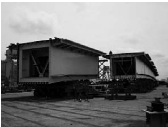
図-11 ユニットキャリアによる地組立状況
