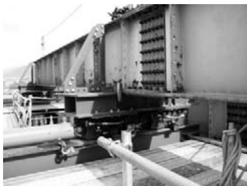
図-7 送出し装置（SD100×2台）
