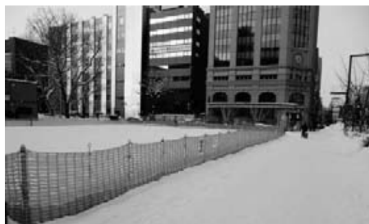
図-1 鉄ピン+1.0m ネットの立入禁止柵
