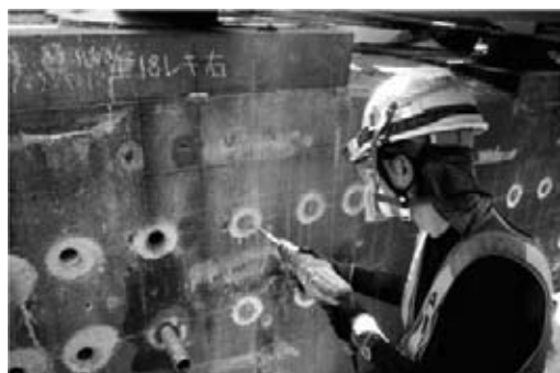
図-3 ハンマードリルによる先行作業
