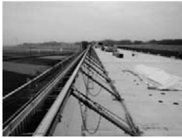
図-8 埋設型枠設置完了
