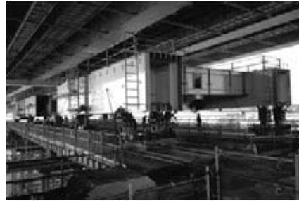
図-4 桁平面ブロック化による縦取り状況
