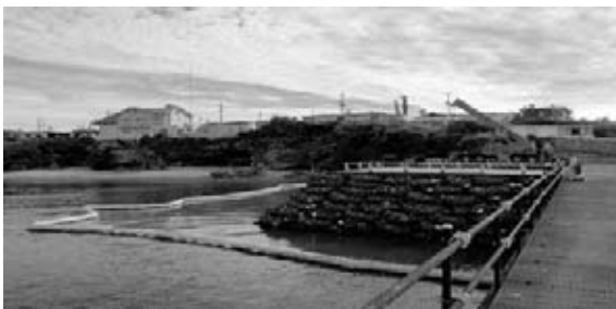
図-3 袋詰め根固め工法の施工状況
