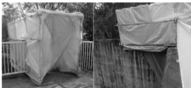
図-3 階段のシート養生
