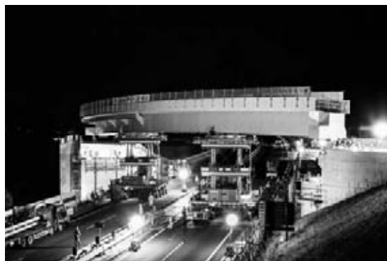
図-3 A2ランプ橋夜間架設
