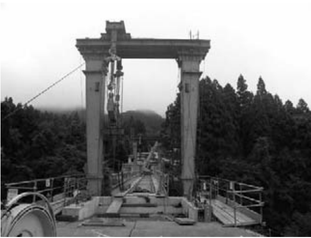
図-3 門構組立完了
