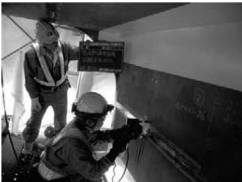
図-11 隅角部磁粉探傷検査実施
