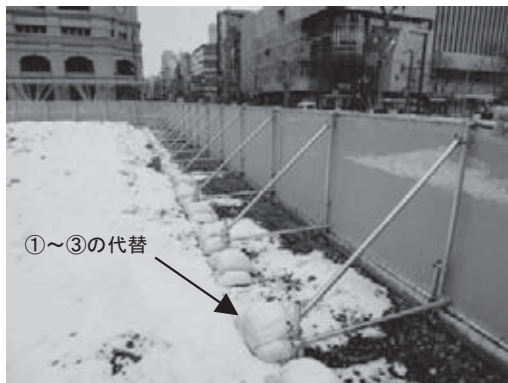
図-3 設置完了（土のうによる重り）
