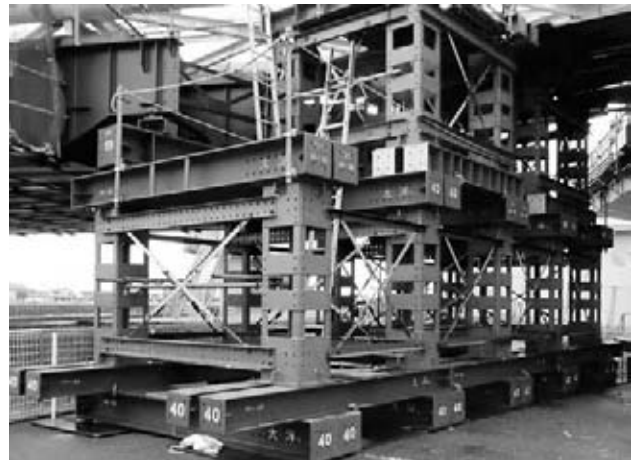
図-5 杭基礎からベント基礎への変更
