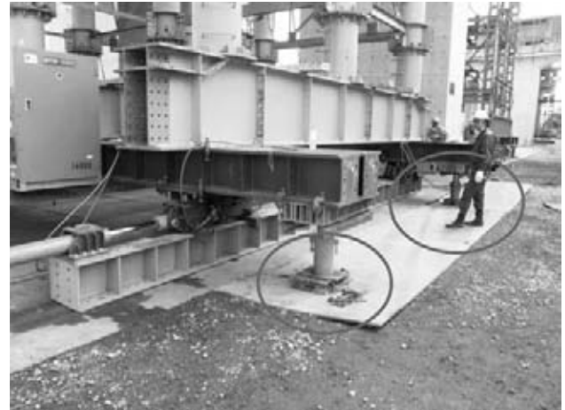
図-8 橋脚付近地盤沈下状況
