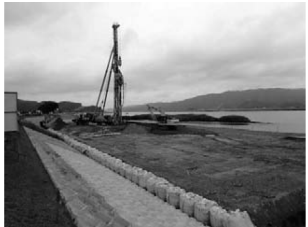
図-1 サンドコンパクション施工
