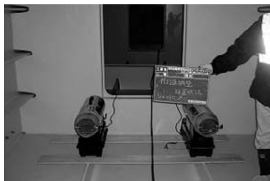
図-4 燃烧型ヒーター設置状況
