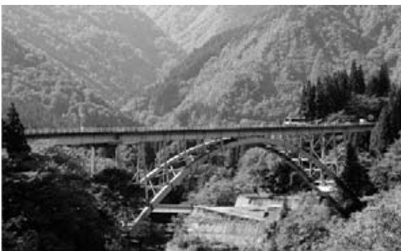
図-1 着工前全景写真
