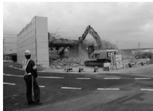
図-4 ボックスカルバート取壊し
