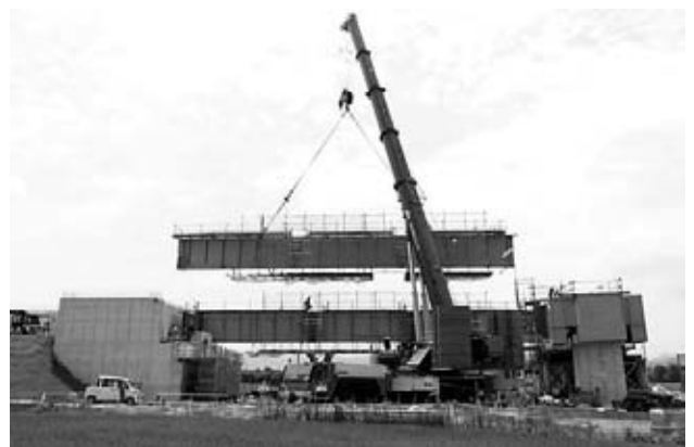
図-8 右岸側主桁架設状況
