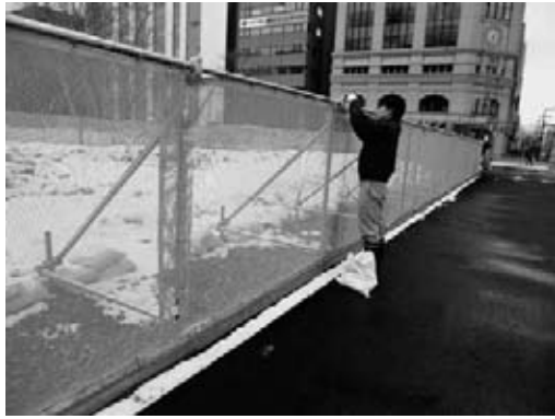
図-2 同系色のクランプカバー設置
