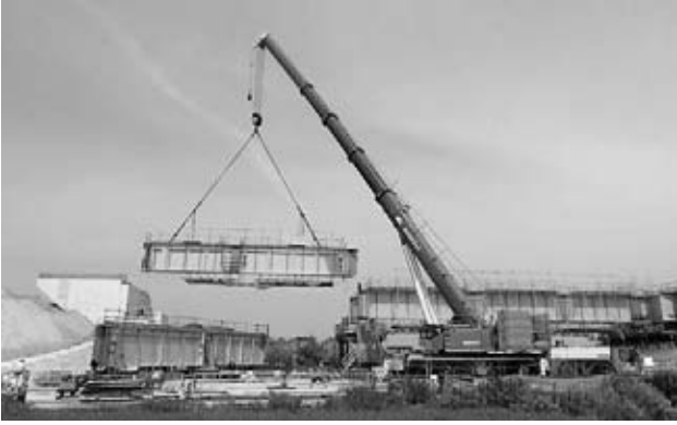
図-9 左岸側主桁架設状況
