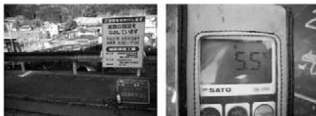
図-1 施工当日外気温
