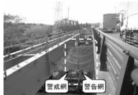
図-3 2段階吊り荷監視システム
