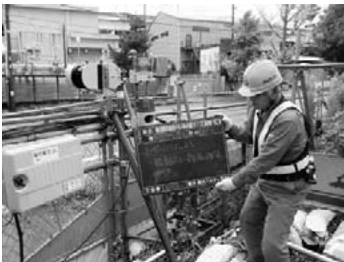
図-7 レーザーバリア設置状況
