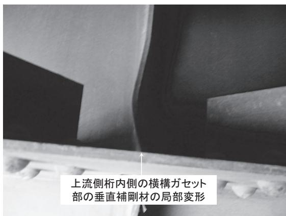
図-3 垂直補剛材の変形
