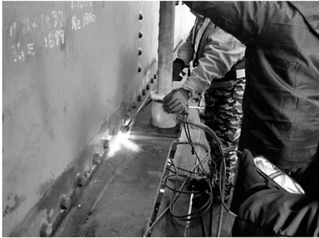
図-7 主桁ウェブ下端の加熱矯正
