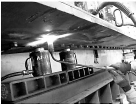
図-8 主桁下フランジ下面からの加熱矯正
