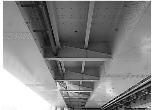
図-7 鋼板接着工法
