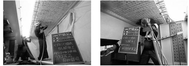
図-6 床版下面補強モルタル撤去工
