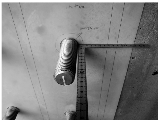
図-6 傾斜アンカーの例
