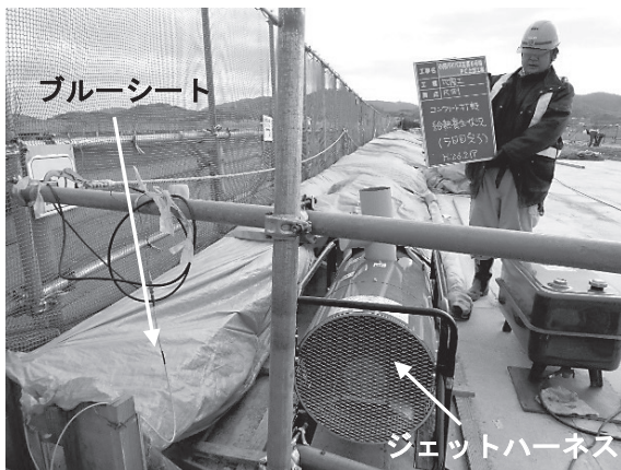
図-4 保温養生状況
