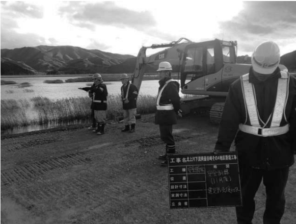
図-10 建設災害防止協会安全指導員現場視察
